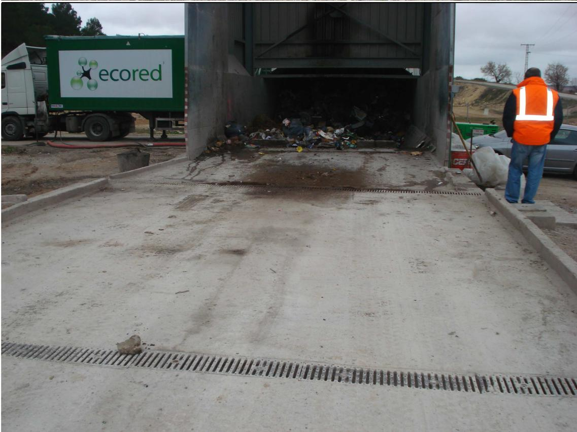
Se ven: las plancha metálicas laterales añadidas; el sistema mejorado de evacuación de lixiviados; y el suelo cimentando para la propia entrada de recolectores (y escaleras para los operarios y/o recolectores)
