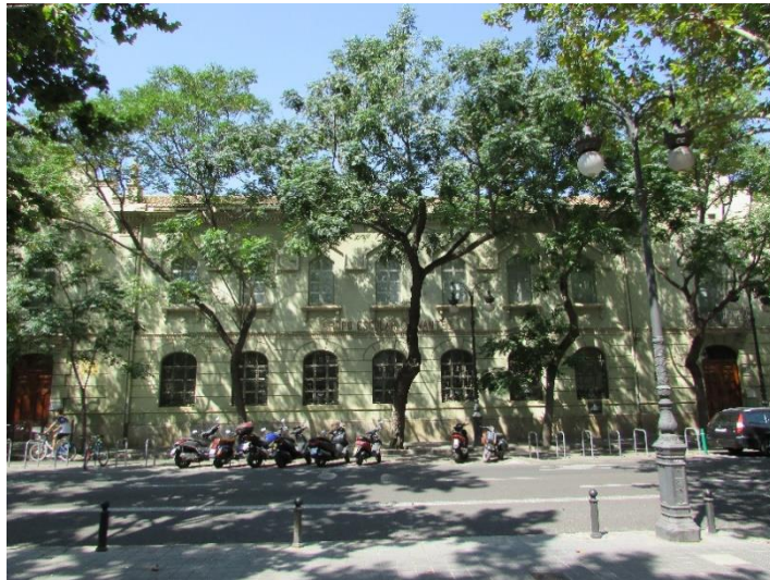
Figura 93 – Grupo Escolar Cervantes en la calle Guillem de Castro, construido en el sitio originario del derribo del antiguo Matadero General de la ciudad. (Fuente: acervo personal de la autora, 2018)
