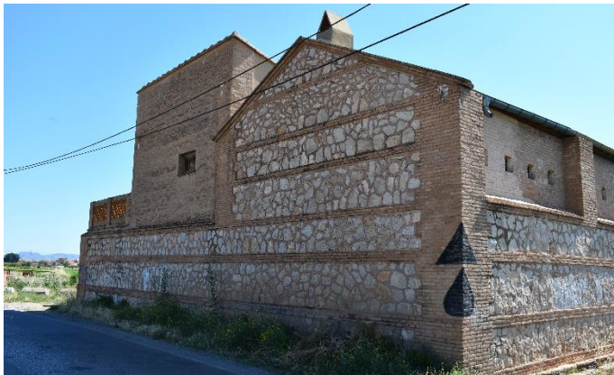
Figura 76 – Detalle de las distintas técnicas constructivas utilizadas en la edificación del Matadero de Borbotó. Se nota que el volumen de la vivienda fue construido con ladrillo, de la misma forma que los cierres de los módulos de las fachadas laterales en la nave de matanza. (Fuente: acervo personal de Gracia López Patiño, 2018)
