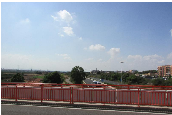
Figura 100 – Vista de la carretera Ronda Norte de Valencia, construida sobre el espacio del antiguo Matadero de Benimámet, entre las acequias de Moncada y de Tormos (Fuente: acervo personal de la autora, 2018)
