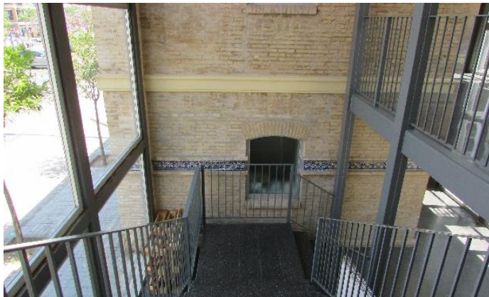
Figura 154 – Escalera compuesta por estructura metálica introducida para conectar las dos plantas del centro de salud. (Fuente: acervo personal de la autora, 2018)
