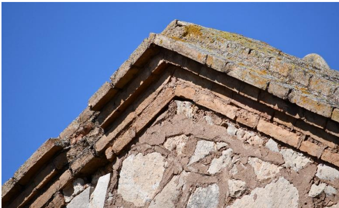
Figura 71 – Vista aproximada del frontón posterior de la nave de matanza, construido en mampostería con detalles en ladrillo. (Fuente: acervo personal de Gracia López Patiño, 2018)
