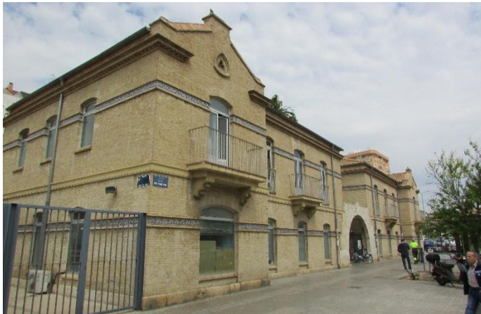
Figura 53 – Vista de la fachada principal del edificio del antiguo Matadero del Distrito del Puerto, donde se observan dos pabellones de dos plantas construidos en fábrica de ladrillo. (Fuente: acervo personal de la autora, 2018)
