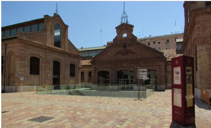
Figura 121 – Vista del acceso principal del conjunto, con el patio central conformado por las tres antiguas naves de matanza. Se nota la presencia de un panel informativo en este punto. (Fuente: acervo personal de la autora, 2018)
