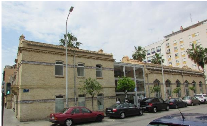
Figura 150 – Vista de la fachada lateral del antiguo Matadero del Distrito del Puerto recayente a la Calle Pedro de Valencia, antiguo Camino de Algirós. (Fuente: acervo personal de la autora, 2018)
