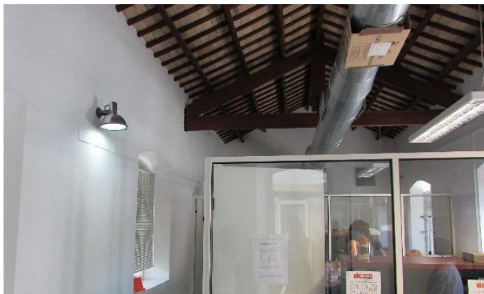
Figura 159 – Vista del área administrativa del actual centro de salud, ubicada en la planta superior de uno de los pabellones delanteros. Se nota la conservación de los cuchillos de madera de la estructura de la cubierta original. (Fuente: acervo personal de la autora, 2018)
