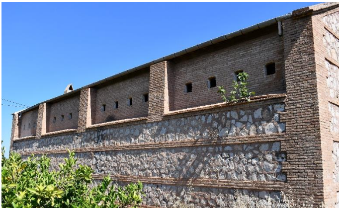
Figura 70 – Fachada lateral del Matadero de Borbotó, donde se observa el muro construido en mampostería con verdugadas de ladrillo y el cierre superior, dividido en cuatro módulos entre pilares, construido con pared en ladrillo que presentan pequeños huecos de forma cuadrada. (Fuente: acervo personal de Gracia López Patiño, 2018)
