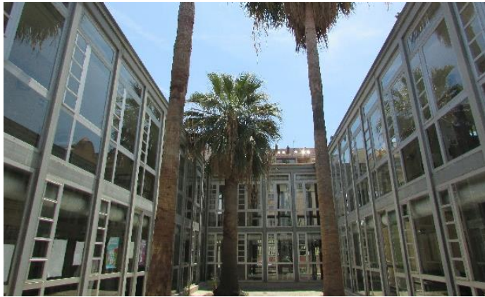
Figura 153 – Vista del patio interno creado con la inserción de la pieza que generó los nuevos pasillos. Destaque para el protagonismo de los perfiles de aluminio anodizado. (Fuente: acervo personal de la autora, 2018)
