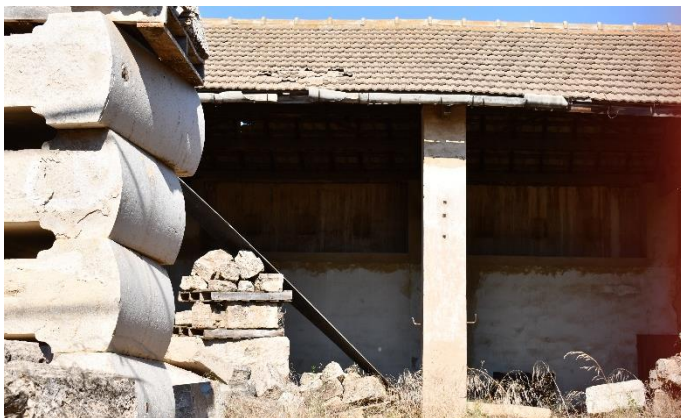
Figura 90 – Otra vista de la edificación correspondiente al antiguo Matadero de En Corts, cuyo volumen lleva una cubierta a dos aguas sostenida por armaduras de madera. (Fuente: acervo personal de Gracia López Patiño, 2018)
