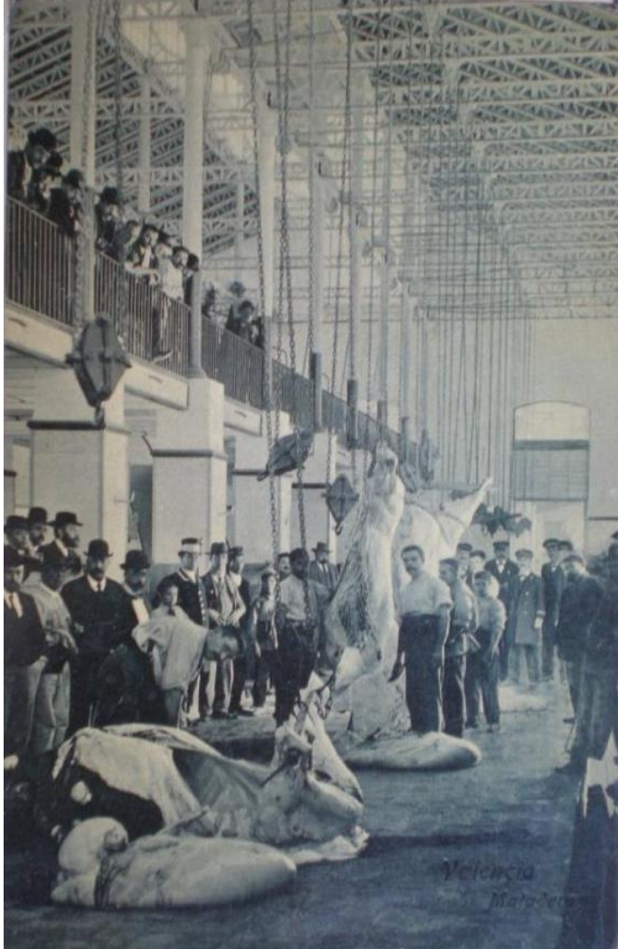
Figura 35 – Vista del interior de la nave de matanza y oreo de ganado vacuno. En la imagen se observa el aparato utilizado para la elevación de las reses y el altillo donde quedaban los interesados a mirar el trabajo de los matarifes. (Fuente: Todocoleccion, 2018 )
