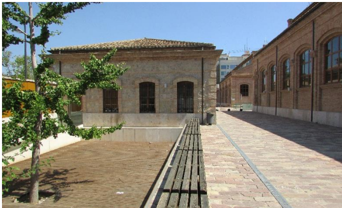
Figura 138 – Área rebajada donde fue creado un espacio de jardín y estar con bancos, originada de la demolición de antiguos retretes. (Fuente: acervo personal de la autora, 2018)
