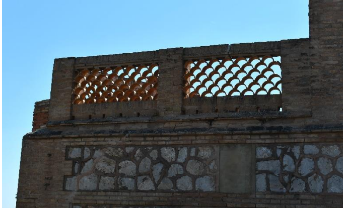
Figura 77 – Detalle del parapeto de la azotea de la vivienda, construido con ladrillo y piezas semicirculares de cerámica que crean oquedades en el muro, confiriendo cierto carácter decorativo al mismo. (Fuente: acervo personal de Gracia López Patiño, 2018)
