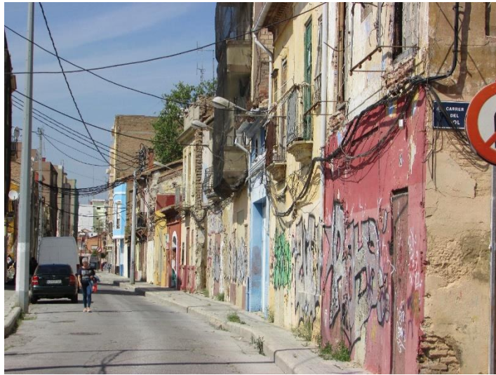
Figura 109 – Vista de la calle San Pedro retratando el entorno inmediato del edificio del antiguo matadero del barrio Cabañal (Fuente: acervo personal de la autora, 2018)
