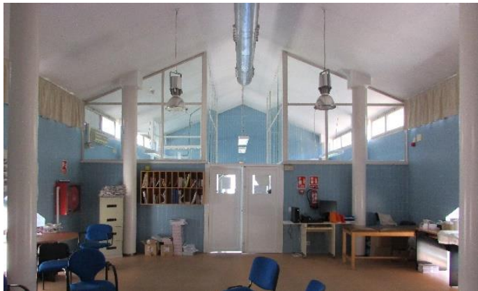
Figura 158 – Vista de una de las salas de actividades introducidas en la planta superior creada en la antigua nave de ganado cerda, donde se observa el tratamiento dado a las cubiertas y el aprovechamiento de la entrada de luz natural. (Fuente: acervo personal de la autora, 2018)
