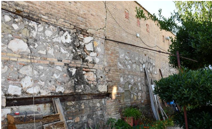
Figura 88 – Vista de la pared posterior del matadero por su cara externa, donde se observa la porción superior construida solo con ladrillos y la presencia de pequeños huecos cuadrados, actualmente tapados. (Fuente: acervo personal de Gracia López Patiño, 2018)
