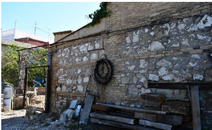
Figura 87 – Vista de parte del muro que contorna el terreno, en su cara posterior, donde se puede visualizar muy bien el sistema constructivo de mampostería y verdugadas de ladrillo. (Fuente: acervo personal de Gracia López Patiño, 2018)
