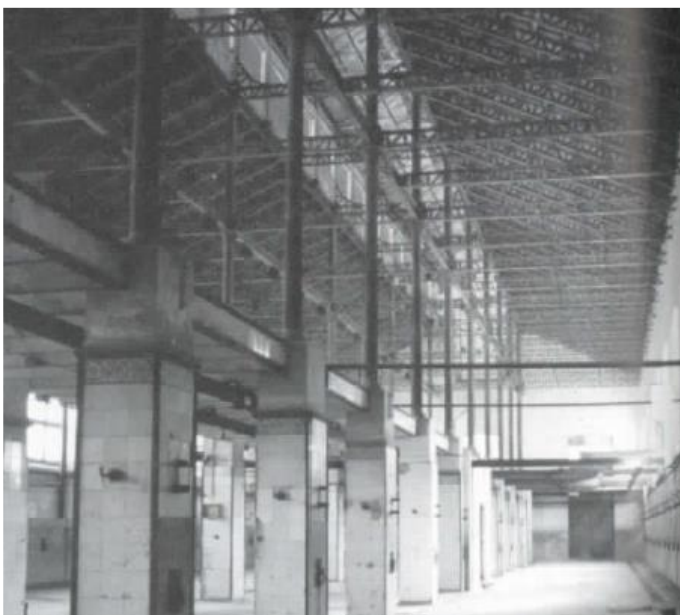
Figura 118 – Otra vista del interior de una de las naves de matanza, donde se observan los paramentos revestidos con azulejos y se puede mensurar la amplitud de este espacio diáfano. (Fuente: TC Cuadernos nº 61, 2004)
