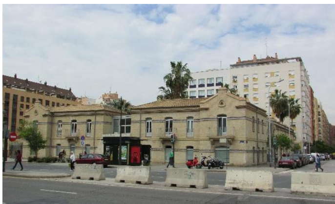
Figura 148 – Vista de la fachada principal del conjunto del antiguo Matadero del Distrito del Puerto recayente a la Calle Serrería. Al fondo, con detalles en cerámica azul en su fachada, el edificio de nueva planta que alberga el Centro de Salud Serrería II. (Fuente: acervo personal de la autora, 2018)
