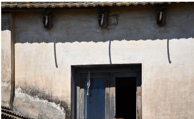
Figura 78 – Vista de la fachada posterior del volumen de la vivienda, donde se nota la pared con revoco, la ventana en madera y las piezas de hierro remanentes del sistema de canalones ahí instalado. (Fuente: acervo personal de Gracia López Patiño, 2018)
