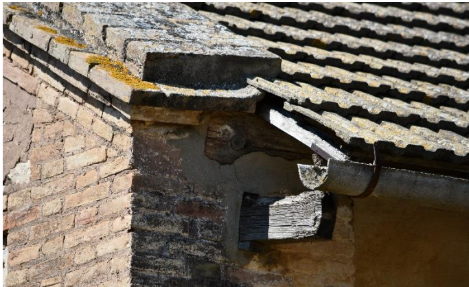
Figura 73 – Detalle de la cubierta de tejas cerámicas planas de la nave de matanza, donde se puede observar parte de su estructura de madera, así como, las piezas de acero en que se cuelga el canalón. (Fuente: acervo personal de Gracia López Patiño, 2018)
