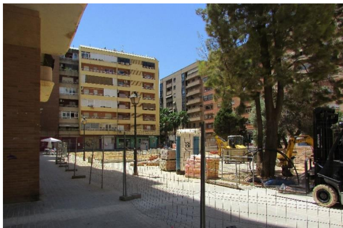
Figura 103 – Plaza interior del conjunto de bloques de viviendas ubicado en el sitio donde estuvo edificado el Matadero de Benimaclet. (Fuente: acervo personal de la autora, 2018)
