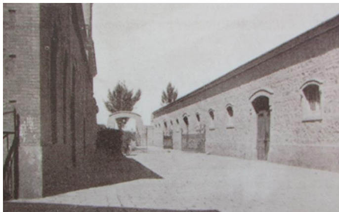
Figura 34 – Vista de la calle lateral destinada al ingreso del ganado lanar y cabrío. A la derecha de la imagen se observa el muro de los corrales destinados a estas reses. (Fuente: panel informativo existente en el Centro Deportivo y Cultural La Petxina)
