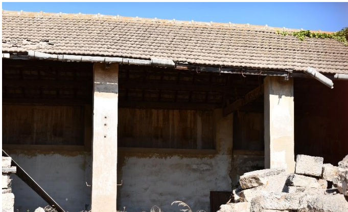
Figura 89 – Vista de la edificación del Matadero de En Corts, una nave sencilla y abierta por su cara delantera, la cual está dividida en cuatro módulos marcados por la disposición de pilares de base cuadrada. (Fuente: acervo personal de Gracia López Patiño, 2018)
