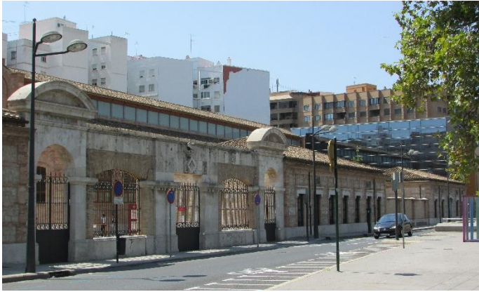
Figura 129 – Vista de la entrada del conjunto desde el Paseo la Pechina. Al fondo, se nota la fachada en vidrio que refleja la imagen de los antiguos edificios del Matadero General. (Fuente: acervo personal de la autora, 2018)
