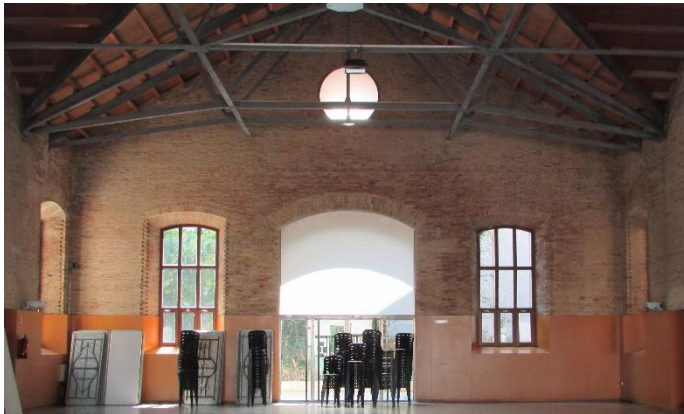
Figura 133 – Vista del vestíbulo del sector cultural, que conecta la biblioteca y la sala polivalente. Se notan los paneles que recubren parte de los muros para esconder las instalaciones, y el restante de los materiales dejados totalmente a vista. (Fuente: acervo personal de la autora, 2018)
