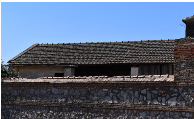
Figura 72 – Vista parcial de la fachada lateral de la nave de matanza, donde se observan los pilares que la dividen en módulos. Se nota un muro de cierre en el módulo a la izquierda y un elemento ejecutado con láminas de madera en el módulo a la derecha. (Fuente: acervo personal de Gracia López Patiño, 2018)
