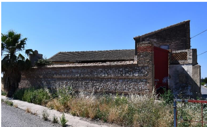
Figura 68 – Vista de la fachada lateral del conjunto del Matadero de Borbotó, donde es posible observar el portón de acceso a la derecha de la foto. El muro que contorna todo el terreno está construido en mampostería con verdugadas de ladrillo. (Fuente: acervo personal de Gracia López Patiño, 2018)
