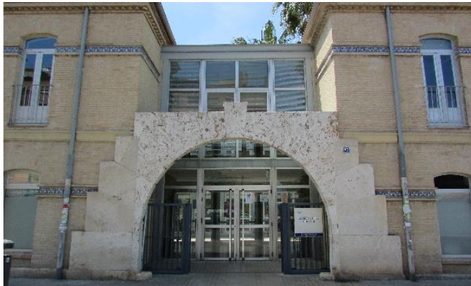
Figura 149 – Arco reconstruido en piedra de mismo color que los arranques preexistentes en el acceso principal del Centro de Salud Serrería I. (Fuente: acervo personal de la autora, 2018)
