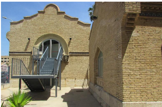
Figura 54 – Vista parcial del conjunto del antiguo Matadero del Distrito del Puerto por su cara posterior, donde se observan los volúmenes construidos en fábrica de ladrillo sobre zócalos de sillería. (Fuente: acervo personal de la autora, 2018)
