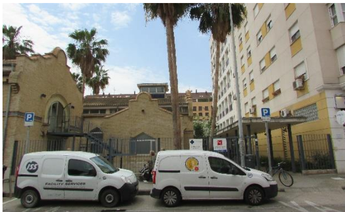
Figura 151 – Vista del acceso en la Calle Pedro de Valencia, construido para llegar al Centro de Salud Serrería II por la parte posterior del conjunto del antiguo Matadero del Distrito del Puerto. (Fuente: acervo personal de la autora, 2018)
