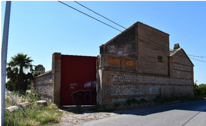
Figura 75 – Vista de la fachada principal del Matadero de Borbotó, donde se destaca el volumen de la edificación de dos plantas, construida para ser utilizada como vivienda del conserje del establecimiento. Al lado del portón del acceso al conjunto, se nota el antepecho de la azotea de esta edificación. (Fuente: acervo personal de Gracia López Patiño, 2018)
