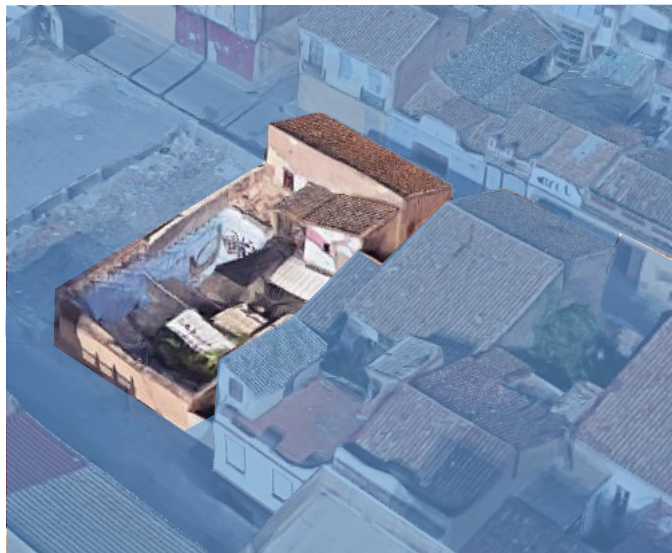
Figura 44 – Situación actual del edificio donde se puede observar la marca de piezas de madera empotradas en todo el muro lateral de cierre indicando allí tener existido una cubierta. Adosado al volumen delantero de la fachada, otro pequeño cuerpo se desarrolla en la lateral del terreno, también con dos plantas, señalando que podría ser ello el remanente de la oficina construida para el veterinario en el proyecto de 1913. (Fuente: adaptación de la autora sobre imagen disponible en Google Maps, 2018)
