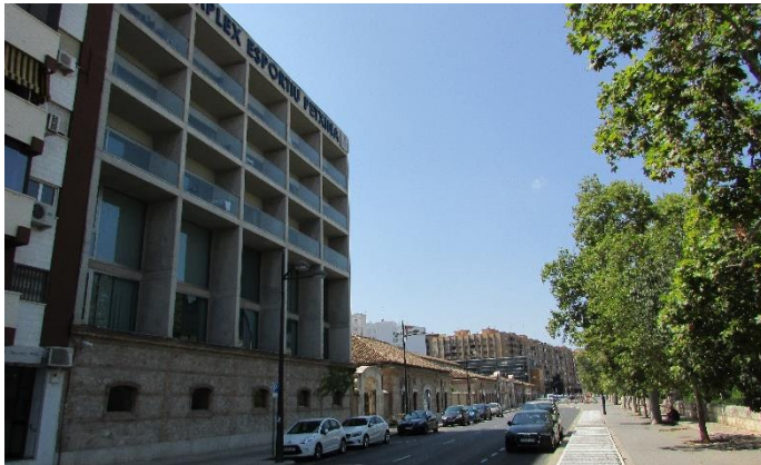
Figura 125 – Vista de la edificación de nueva planta construida para albergar el sector residencial del complejo. Se observa que fueron mantenidos los antiguos muros de cierre del corral de reses lanares. (Fuente: acervo personal de la autora, 2018)
