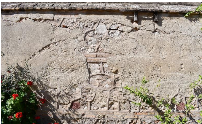
Figura 86 – Vista aproximada del muro lateral, donde se puede observar su sistema constructivo compuesto por mampostería ordinaria con verdugadas de ladrillo. (Fuente: acervo personal de Gracia López Patiño, 2018)
