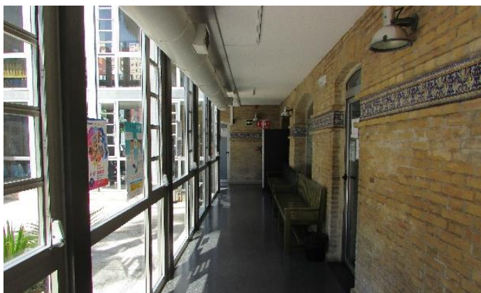
Figura 152 – Vista del pasillo formado en la planta baja con la inserción de la nueva pieza que conecta todos los antiguos volúmenes del matadero. (Fuente: acervo personal de la autora, 2018)
