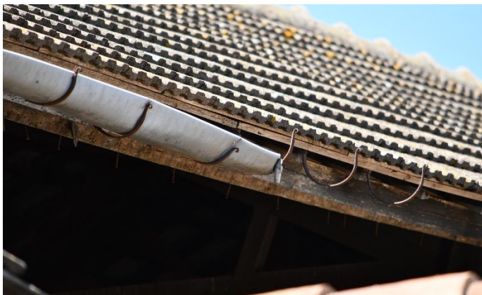
Figura 74 – Detalle del canalón y su sistema de fijación en el alero. Se observa también la armadura del tejado, ejecutada en madera. (Fuente: acervo personal de Gracia López Patiño, 2018)
