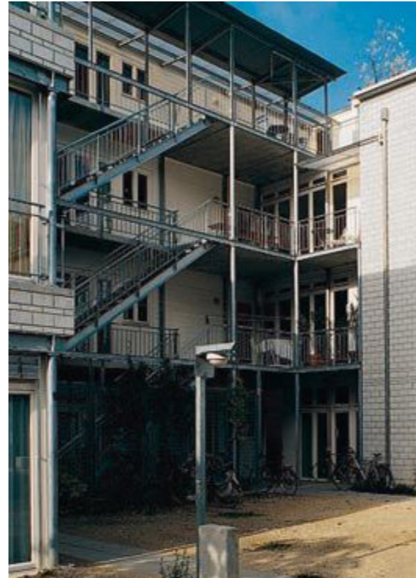
Figura 57. Überbauung Hellmutstrasse - ADP Architektur und Planung. Escalera de acceso viviendas.
