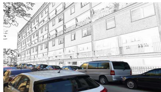
Fig. 185; Fig. 186; Fig. 187: Apropiación de la calzada junto a la Casa Bloc por los vehículos que se estacionan en su contorno.
