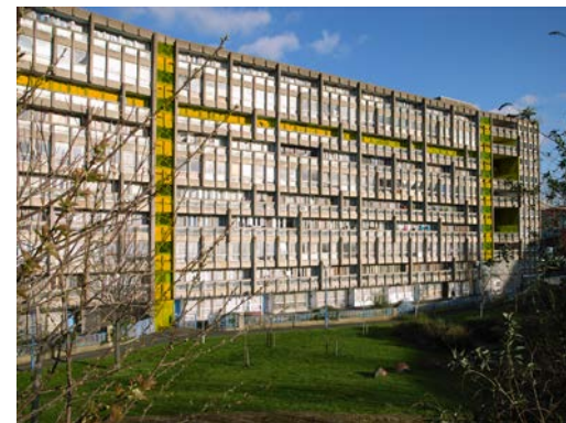
Fig. 240: Fachada exterior este Robin Hood Gardens. En color corredores peatonales (calles en el aire) de acceso a las unidades de vivienda.
