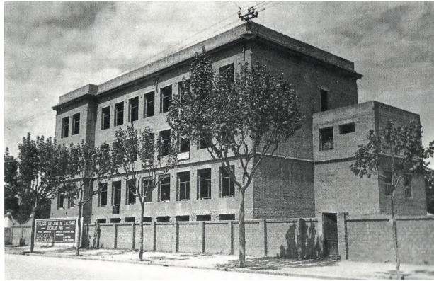
Figura 19: Estado del antiguo edificio del Colegio Alemán de Valencia en la calle Doctor Simarro.
