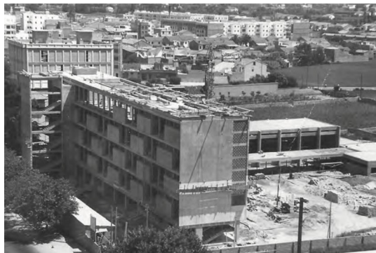
Figura 29: Esqueleto de hormigón armado durante la fase de construcción del DSV.
