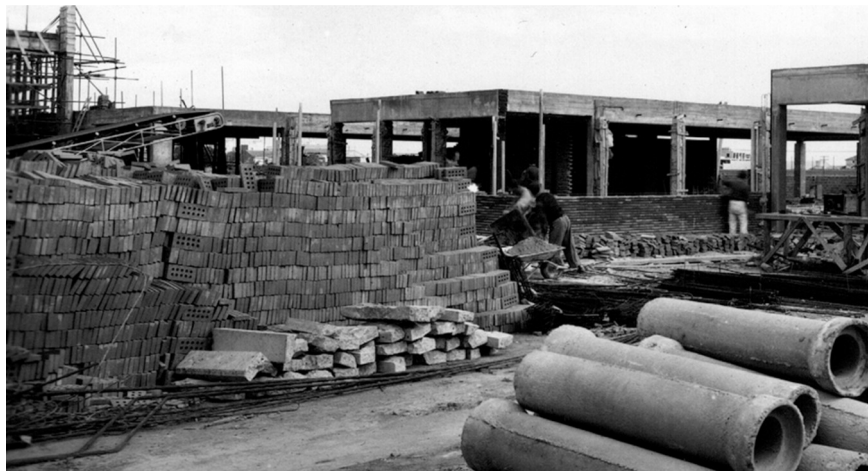
Figura 31: Acopio de ladrillos en la construcción de los muros del Kindergarten del DSV.
