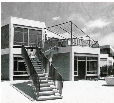
Figura 42: DSM de Concha espina. Kindergarten. Vista del acceso a las terrazas asociadas a las aulas.
