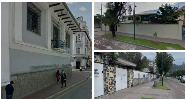
Ejemplo de fachadas pasivas en las que no se realiza ninguna actividad.
