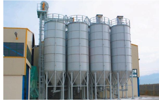
Ilustración 32. Silos de acero al carbono.
