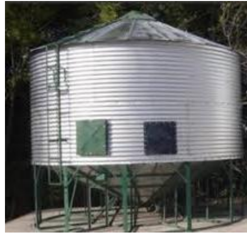
Ilustración 33. Silo cilíndrico de flujo de embudo.
