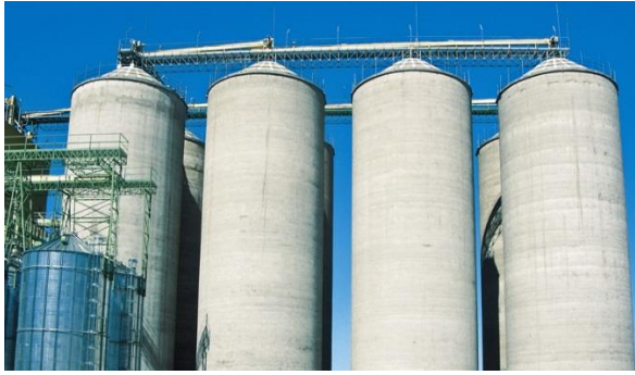
Ilustración 31. Silos de hormigón
