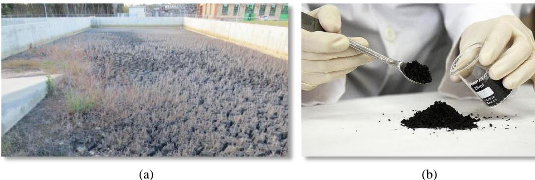
Figura 4.2. (a) Era de secado ETAP la Presa y (b) fango procesado.
