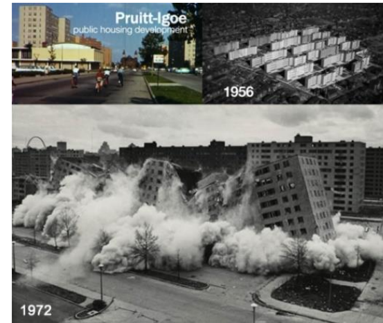
Fig. 17 Demolición de Pruitt-Igoe.1972. Fuente: hyperallergic.com
