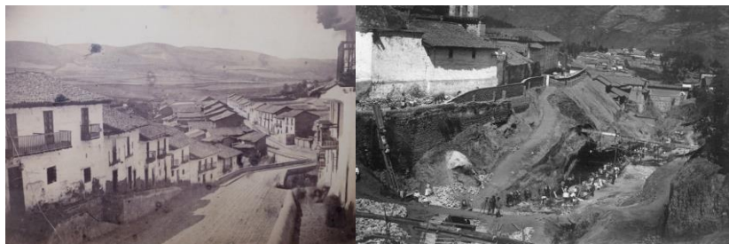
Fig. 52 Quebrada del barrio San Sebastián. Fuente: fotografianacional.gob.ec
