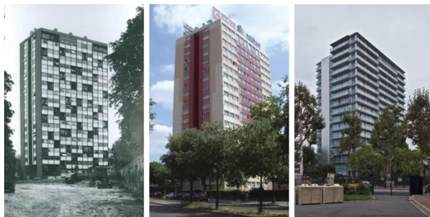
Fig. 43 Diferentes intervenciones en la torre. Fuente: metalocus.com
