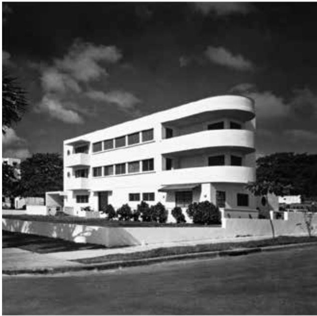
Edificio El Jaragüita Santo Domingo. República Dominicana. 1942. Fuente: Trazos en el mar: Guillermo González, arquitecto de la modernidad dominicana
