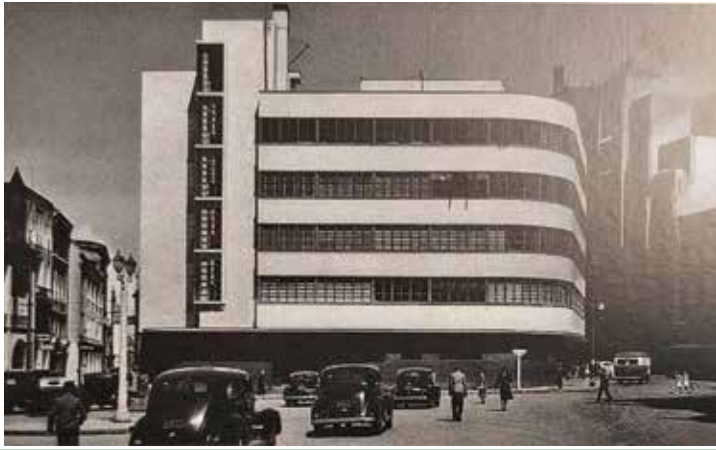
Edificio de Correos de Valparaíso, Chile.
