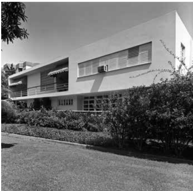
Residencia Pichardo, Santo Domingo, República Dominicana. Fuente: Trazos en el mar: Guillermo González, arquitecto de la modernidad dominicana
