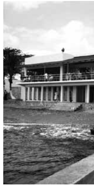
Casino de Güibia. Santo Domingo, República Dominicana. Fuente: Trazos en el mar: Guillermo González, arquitecto de la modernidad dominicana
