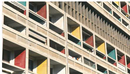
Fig.30. Detalle fachada este, brise-soleil, 2004.
