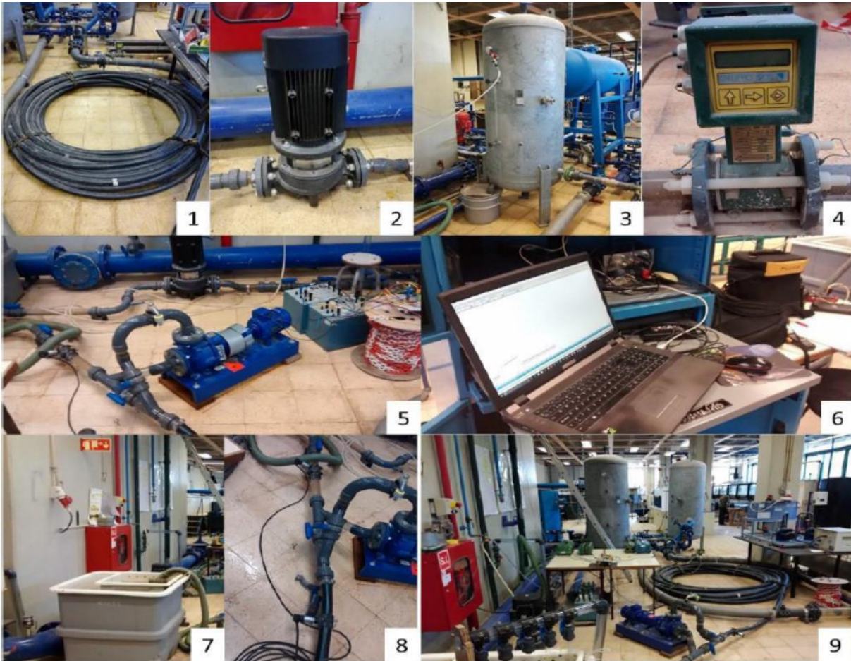
Figura 17 Vista detallada componente a componente de la en instalación experimental
