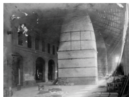
Imagen 36. Interior de una de las naves, con la cámara de combustión de un horno. (fuente: CIDCeN)
