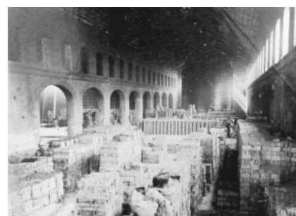
Imagen 37. Interior de una nave donde se observa el acopio de ladrillos refractarios. (fuente: CIDCeN)
