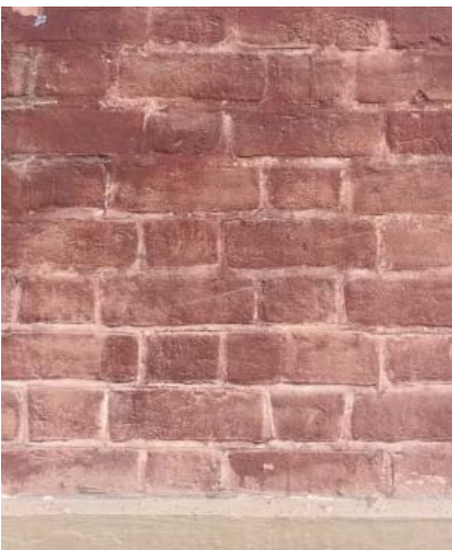
Imagen 34. Detalle del aparejo del edificio de oficinas del conjunto fabril en la actualidad. (fuente: Angela López Sabater)
