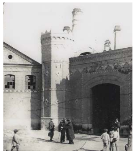
Imágenes 38 a 41. Instantáneas de los trabajadores en varias ubicaciones de la fábrica.(fuente: Ayuntamiento de Meliana)
