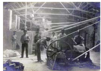
Imagen 28. Trabajadores delante de un molino triturador movido por el vapor. Se transmite la fuerza, a todas las máquinas de la nave, mediante una red de correas. (Fuente: Ayuntamiento de Meliana)
