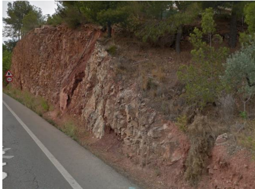
Imagen 21. Talud en el margen derecho de la calzada. Fuente: realización propia.
