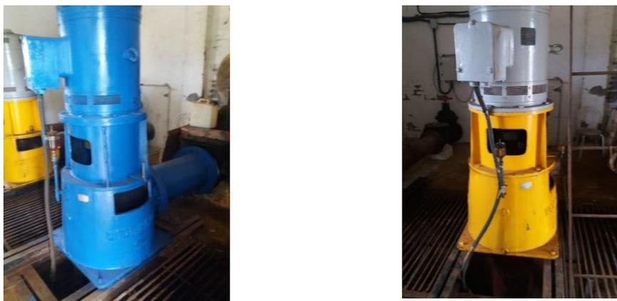
*Figura 36. Bombas que drenan el humedal. A la izquierda la de Castellón y a la derecha la de Benicasim*
