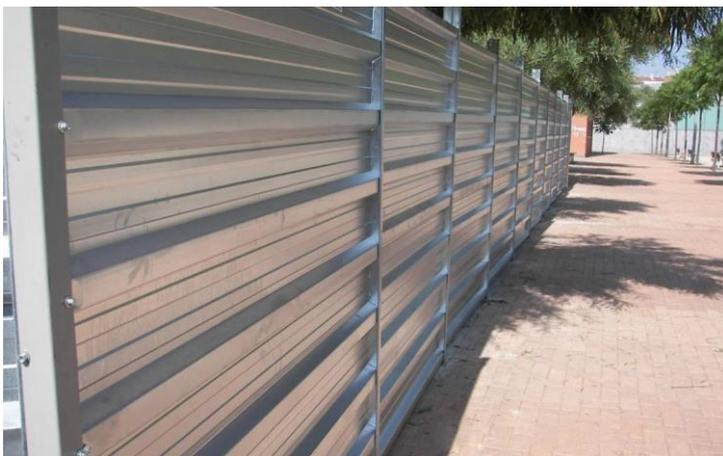
Figura 67. Valla de chapa galvanizada, totalmente opaca y permite cerrar una zona de obras de forma provisional. De 2 o 3 m. de altura.
