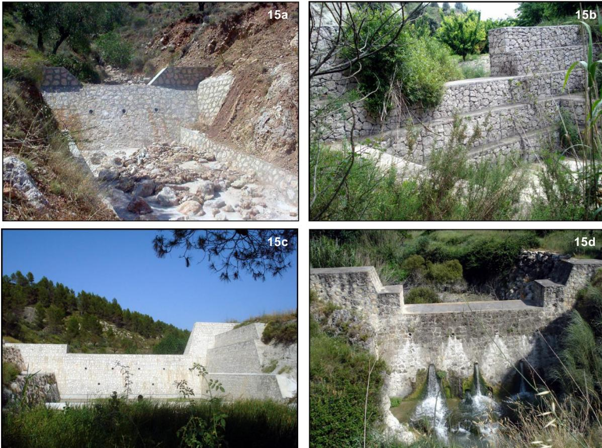
**Fotografía 15.** Diques construidos en la cuenca del Serpis, aguas arriba del embalse de Beniarrés. **15a)** Dique 3 sobre el Bco. del Cementerio en Cocentaina. **15b)** Dique 6 en el Bco. d'Almudaina, Municipio Planes. **15c)** Dique 14 sobre el río Valleseta en el límite de los TT.MM. de Benilloba y Gorga. **15d)** Dique 12, construido en el río Penaguila en el municipio del mismo nombre.
