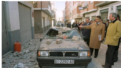
FIG. 6. Restos de cornisas y antepechos de cubiertas cayeron sobre las calles de Mula en el terremoto de 1999.
