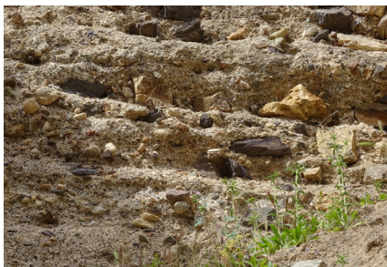
FIG. 10. Detalle de tongadas y mampuestos sobre L6.
