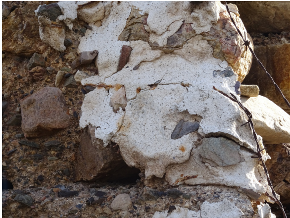
FIG. 69. Torre 2. A finales del siglo XX los propietarios cercaron todo el recinto colocando alambres y conectándolos a los muros originales con pelladas de yeso.
