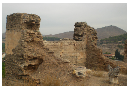
FIG. 11 y 12. Comparativa de imágenes. Se observa un pequeño descenso de los niveles del muro como consecuencia de la exposición atmosférica. Fotografías de 2011 (fig. 11) y 2017 (fig. 12).
