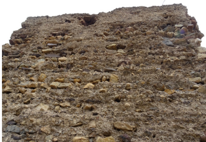
FIG. 3. Tapia de calicanto en la torre de la cara Suroeste del recinto superior del Castillejo.
