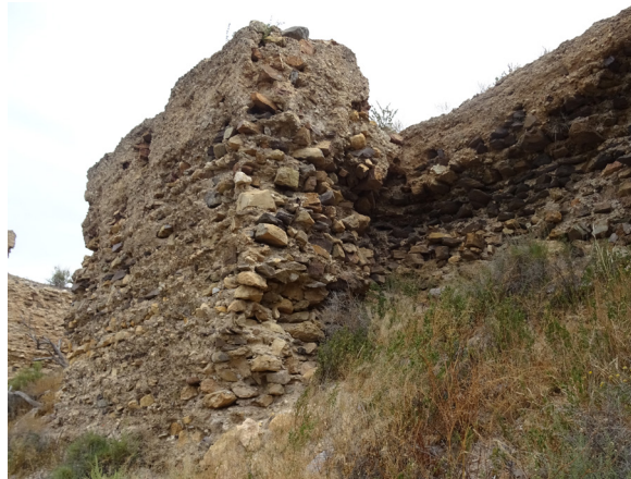
FIG. 31. Torre 15. Encuentro de la torre 15 con el lienzo 11. Las capas externas del muro han sido erosionadas profundamente, ocasionando una pérdida de material importante y dejando a la vista el mampuesto interno.
