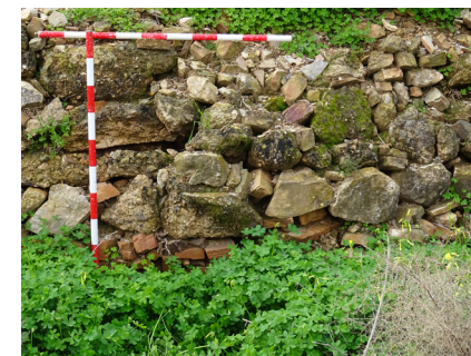
FIG. 32. Reutilización de partes de muro histórico para creación de terrazas.
