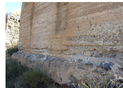
FIG. 12. Detalle de la zarpa de la T24 en el recinto inferior.
