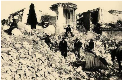
FIG. 1. Terremoto de Arenas del Rey (Granada) con una intensidad X.
