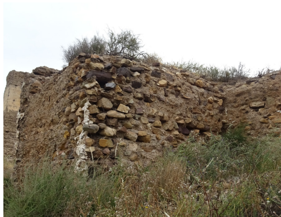
FIG. 42. Torre 2. La vegetación de tipo leñosa se afianza y crece sobre su superficie alterándola y generando nuevos accesos para el agua y otros agentes atmosféricos.
