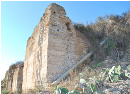
FIG. 29. Tubería de PVC junto a la torre 24 en el recinto inferior.
