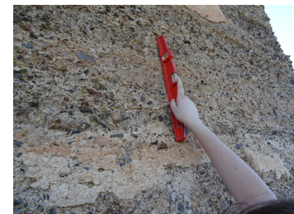
FIG. 31. Revisión de desplomes con nivel de burbuja sobre la torre 4.
