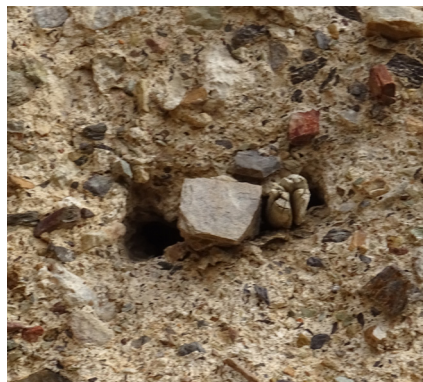
FIG. 14. Detalle de una aguja circular en la cara Oeste de la T12.
