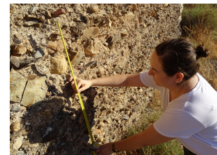
FIG. 5. Toma de datos y medición de la distancia entre agujas.
