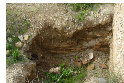
FIG. 13 y 14. Comparativa de imágenes. Muchos ladrillos se han desprendido y se han perdido. Fotografías de 2013 (fig. 13) y 2017 (fig. 14).
