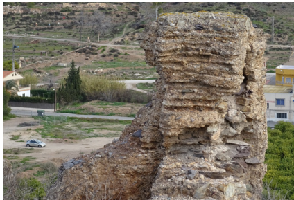
FIG. 2. Huella de las tongadas de la mezcla que compone la tapia en la sección de la T7.
