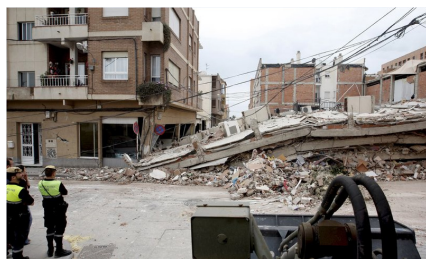
FIG. 7. Un edificio se derrumba y produce importantes daños estructurales a otro, durante el terremoto de Lorca de 2011.
