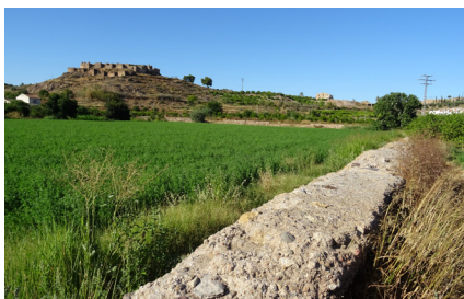
FIG. 28. Muro de la gran alberca en las proximidades del Castillejo de Monteagudo.
