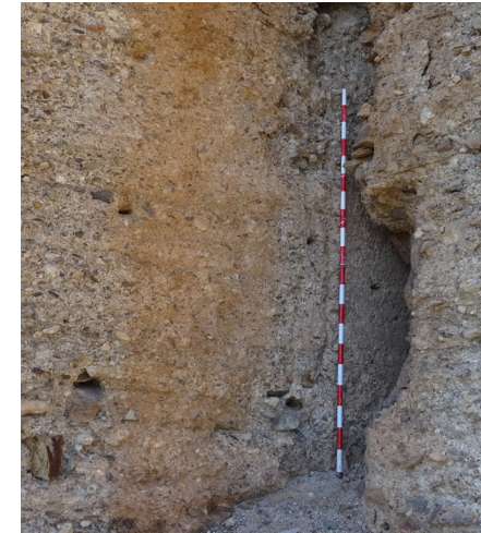
FIG. 23. Encuentro entre T8 y T9. Se puede ver con facilidad la alternancia de fábricas.
