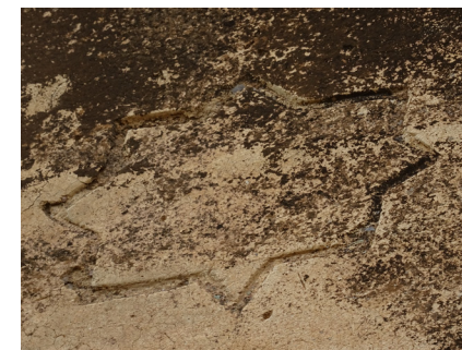
FIG. 10. Estrella de ocho puntas esgrafiada sobre el revestimiento histórico de la torre en la esquina Noreste.
