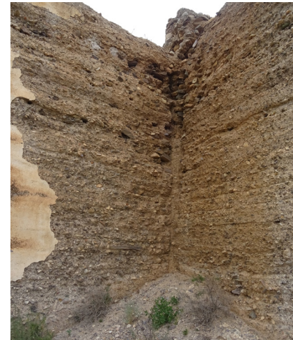
FIG. 26. Independencia de las fábricas en la esquina entrante entre T1 y T16.
