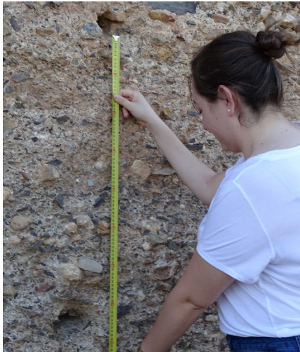
FIG. 35. Medición con flexómetro in situ, distancia entre mechinales en la T4.
