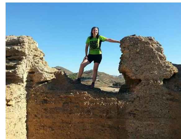
FIG. 68. Torre 24. El desarraigo patrimonial y la falta de comportamiento cívico provoca situaciones de peligro tanto para el monumento como para las personas.
