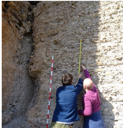
FIG. 5. Toma de datos sobre la T8 y medición de la distancia entre agujas.
