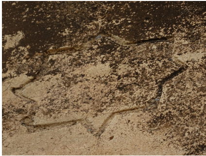
FIG. 2. Estrella de ocho puntas esgrafiada sobre revestimiento original.
