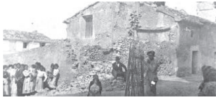
FIG. 5. Daños causados por el terremoto de Lorquí de 1911.
