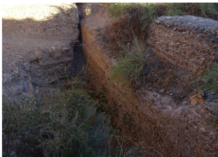
FIG. 19. Interior de la T4. Se aprecia la independencia con el muro interior.
