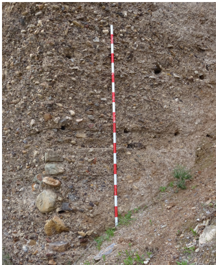
FIG. 36. El jalón mide con escala gráfica la distancia entre mechinales en la T8.
