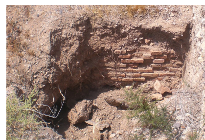
FIG. 13 y 14. Comparativa de imágenes. Muchos ladrillos se han desprendido y se han perdido. Fotografías de 2013 (fig. 13) y 2017 (fig. 14).
