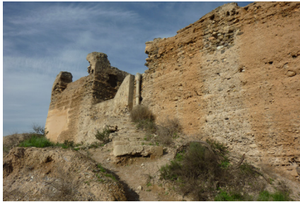
FIG. 9. Acceso a los interiores por una escalera en mal estado en su cara Sureste.
