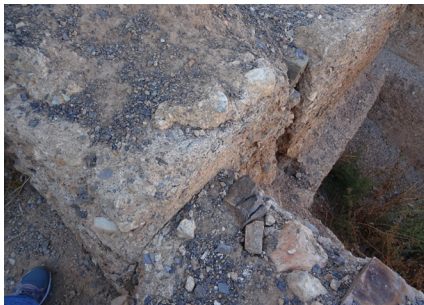
FIG. 18. Encuentro del muro del recinto interior con T3 y T4
