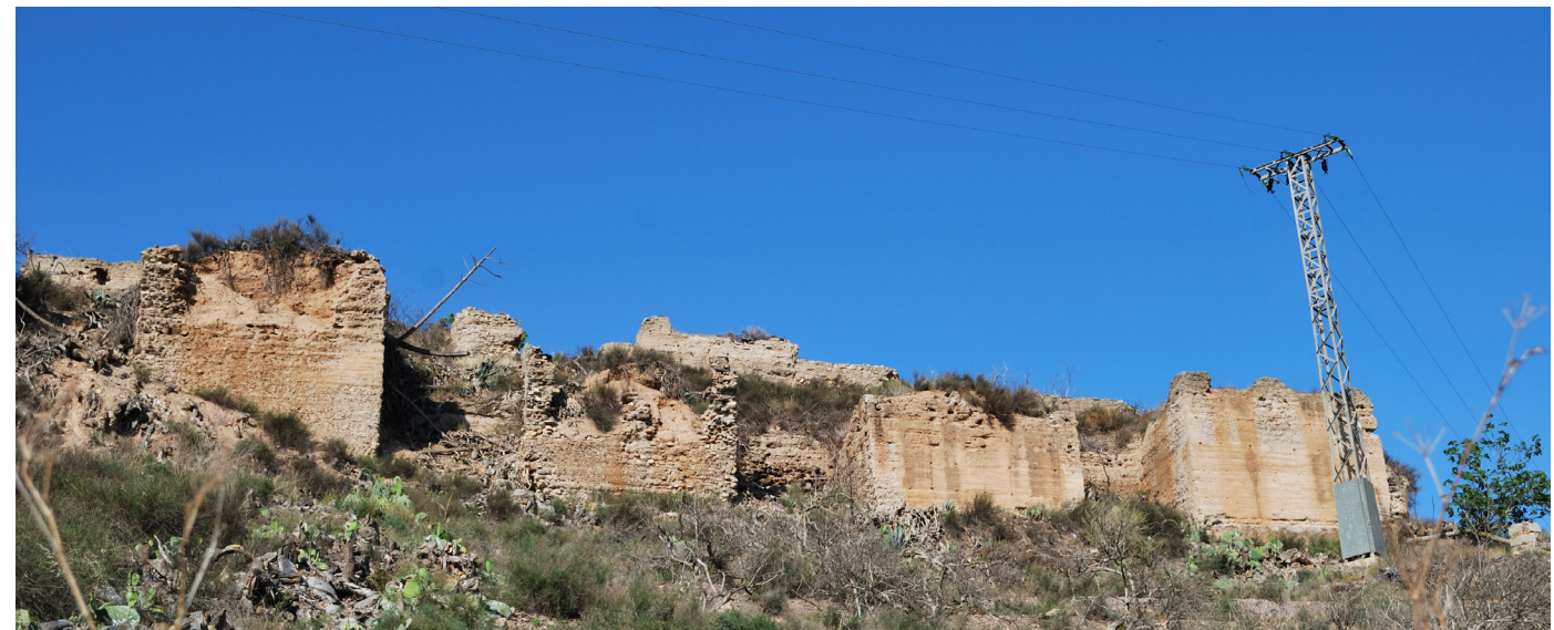
FIG. 30. Torre eléctrica junto al recinto inferior, delante de la torre 24. Tanto la torre como el cableado distorsionan la imagen histórica del monumento, el paisaje tradicional de la huerta y del Sitio Histórico.
