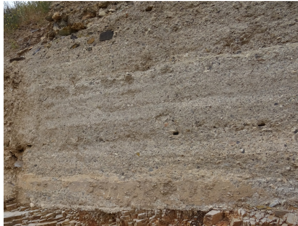
FIG. 39. Torre 6. En la parte inferior de la zarpa, inmediatamente sobre la roca, se detectan algunas partes de costra en estado avanzado de deterioro por efecto de la erosión.
