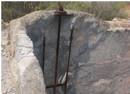
FIG. 28. Accionamiento y compuerta de la balsa en los interiores del Castillejo.
