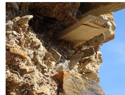
FIG. 5. Aguja presente en los muros del Castillejo de Monteagudo.
