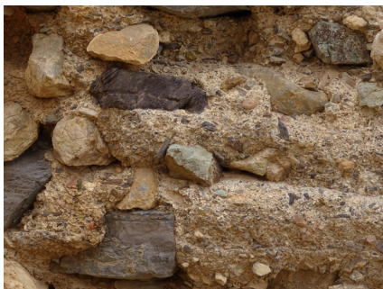
FIG. 3. Detalle de la unión del mampuesto de calicanto con las tongadas en la T9.
