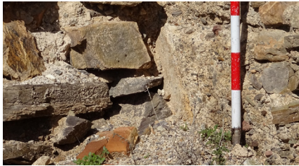
FIG. 28. Detalle del resto de revestimiento hallado en el encuentro entre T13 y L9.
