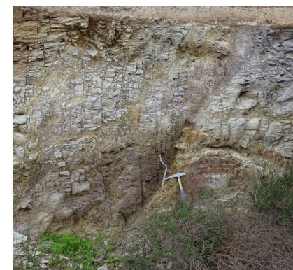
FIG. 14. Hallazgo de una falla bajo la torre 5 del Castillejo de Monteagudo.
