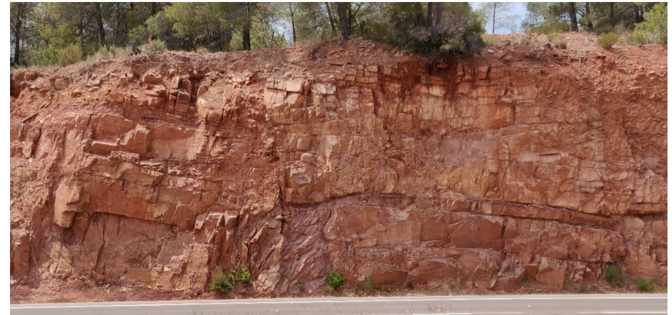
Imagen 9. Talud situado junto a la intersección de estudio. Fuente: Propia.
