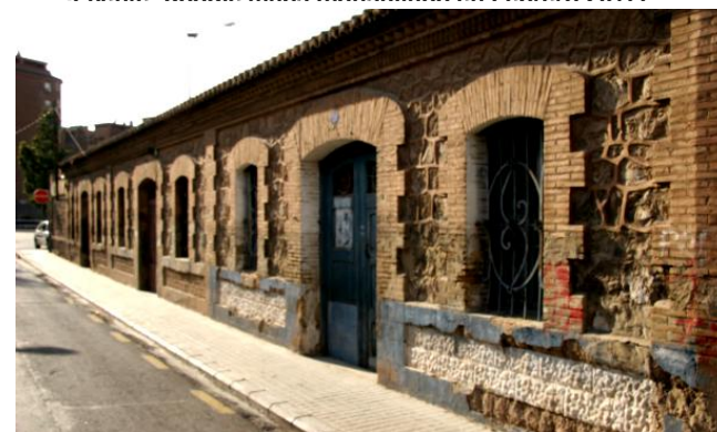
Figura 9. Fachada viviendas Ramón de Castro. Fuente: Elaboración propia
