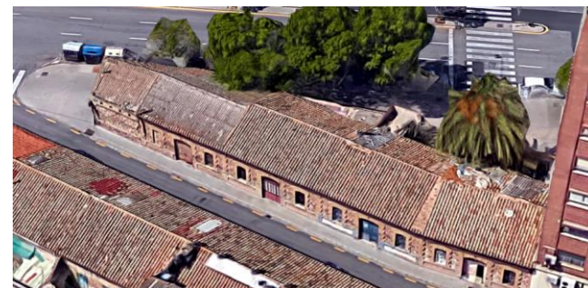
Figura 10. Imagen aérea viviendas Ramón de Castro. Fuente: google maps (consultado en Febrero 2017)
