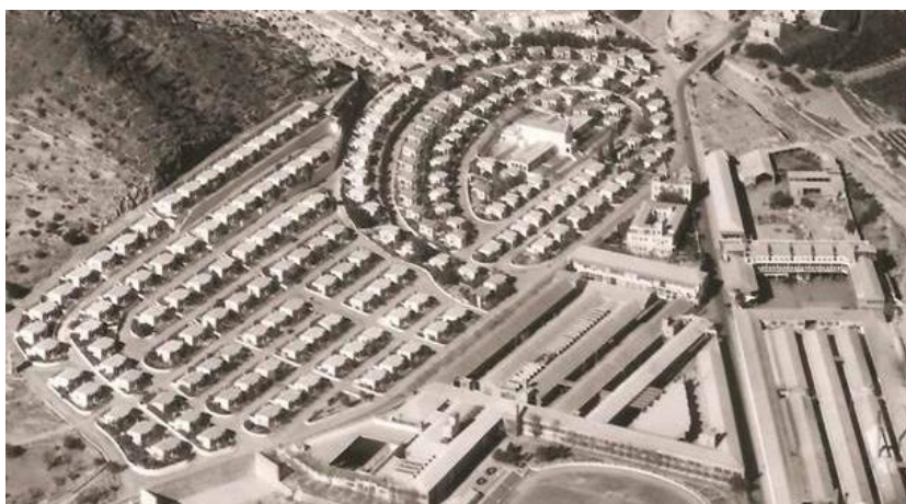
Figura 42. Imagen aérea Barrio obrero Colonia Segarra. Año 1955 Fuente: Vall de Uxo en el Recuerdo
