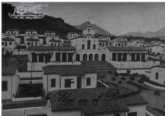
Figura 45. Imagen de la Iglesia y las viviendas obreras Año 1945 Fuente: Vall de Uxo en el recuerdo
