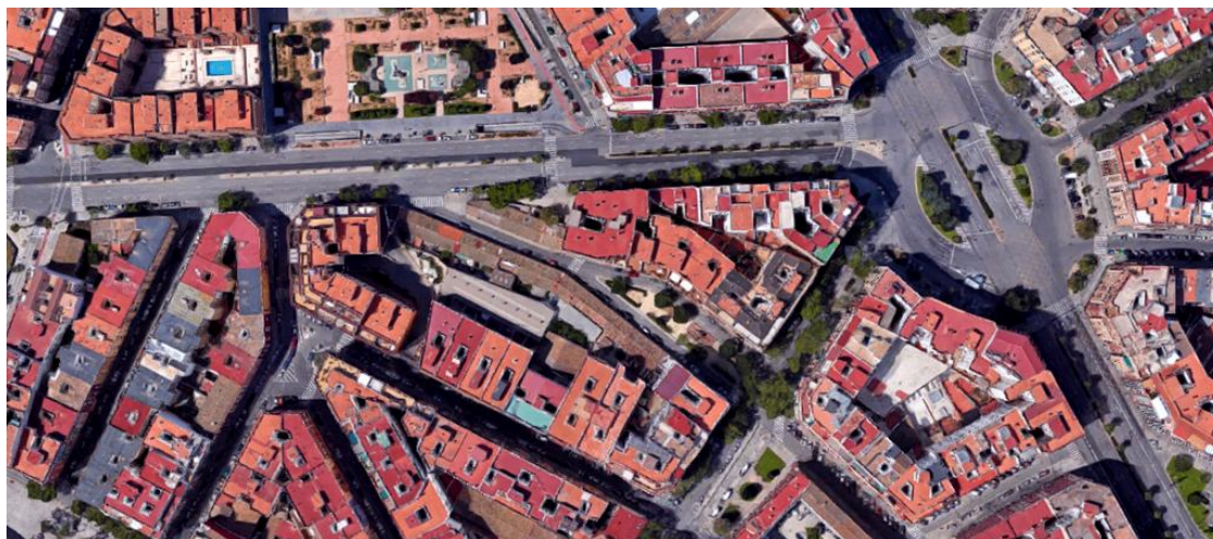
Figura 6. Imagen aérea viviendas Ramón de Castro. Fuente: google maps (consultado en Febrero 2017)
