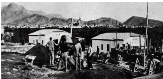
Figura 40. Construcción de las viviendas. Año 1943 Fuente: Vall de Uxo en el recuerdo
