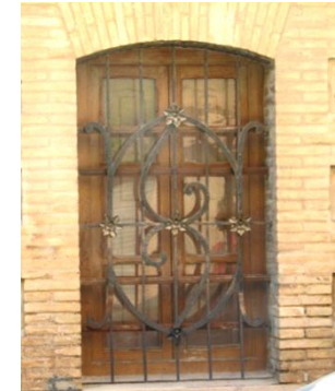
Figura 51. Carpintería exterior Fuente: Elaboración propia
