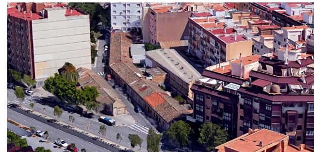
Figura 8. Imagen aérea viviendas Ramón de Castro. Fuente: google maps (consultado en Febrero 2017)
