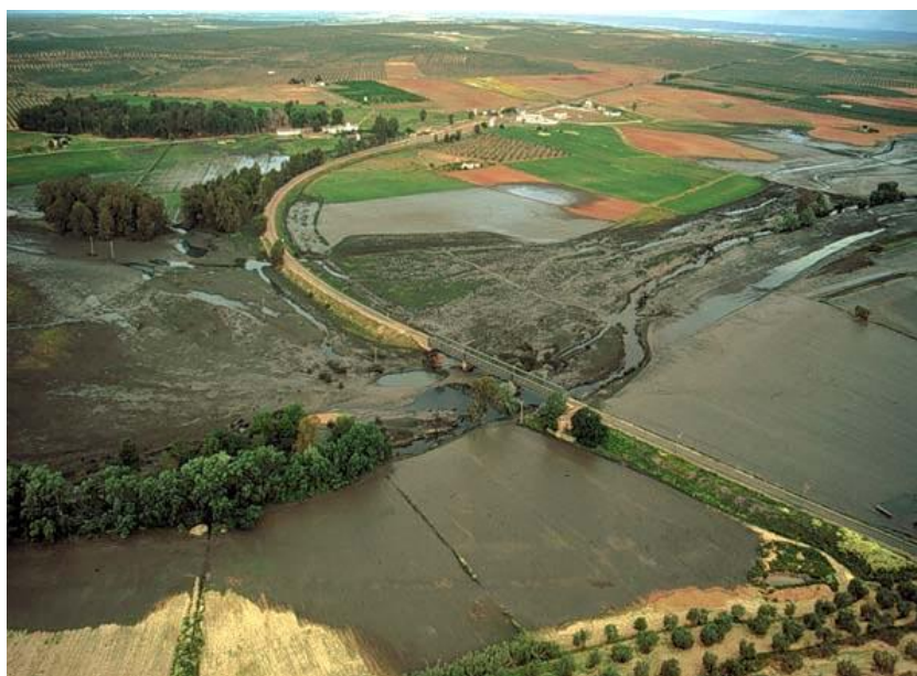
Ilustración 6. Estado del cauce y sus riberas en las proximidades de Aznalcázar.
