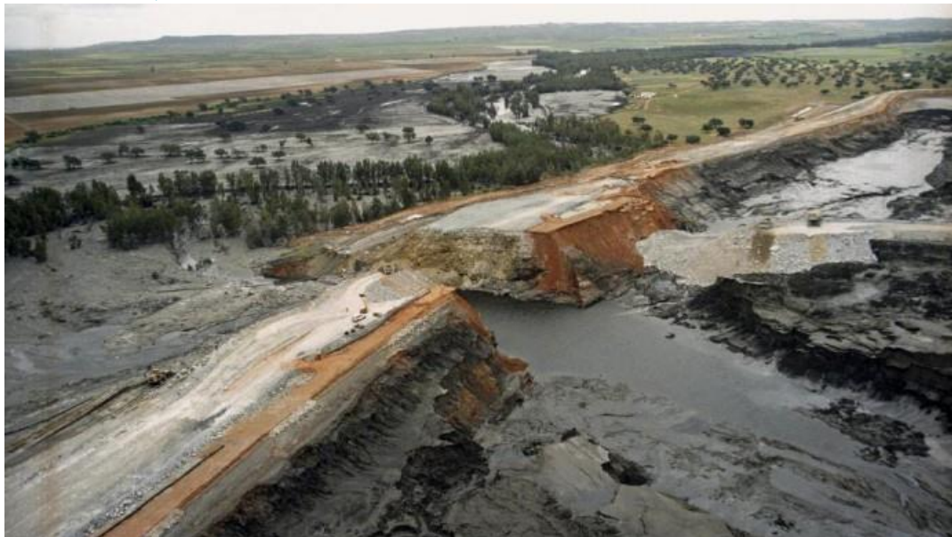
Ilustración 9. Punto de rotura de la balsa de residuos.
