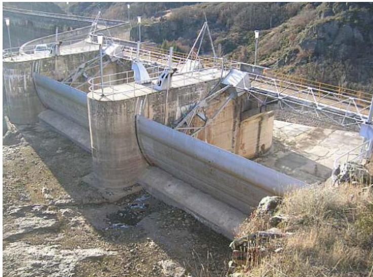
Figura Ñ.8: Compuertas Taintor de la presa de Requejada desde aguas arriba.
