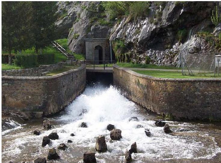
Figura Ñ.6: Salida de agua al cauce del desagüe de fondo de la presa de Cervera.
