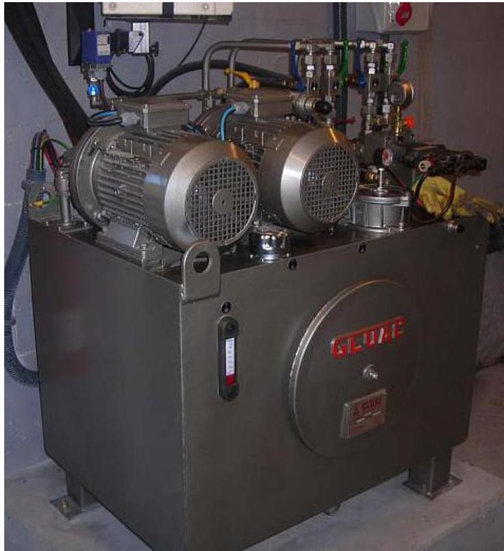
Figura Ñ.14: Grupos oleohidráulicos de accionamiento de las compuertas del aliviadero de la presa de Aguilar de Campoo.
