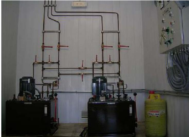
Figura Ñ.9: Grupos oleohidráulicos de accionamiento de las compuertas del aliviadero de la presa de Requejada.
