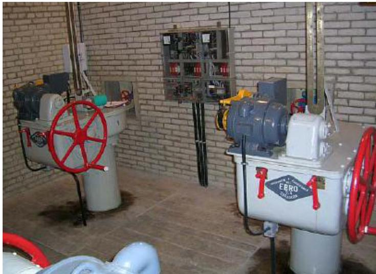
Figura Ñ.11: Cámara de válvulas del desagüe de fondo de la presa de Requejada.
