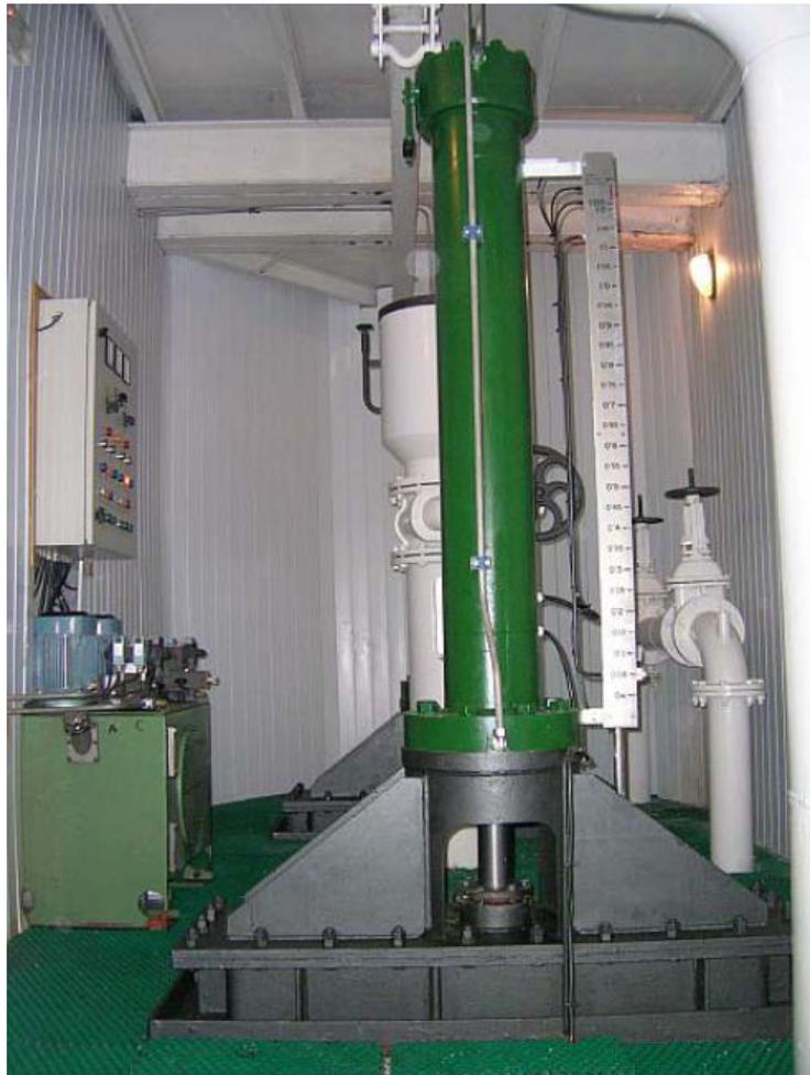
Figura Ñ.4: Válvula de regulación de desagüe de fondo de la presa de Cervera.
