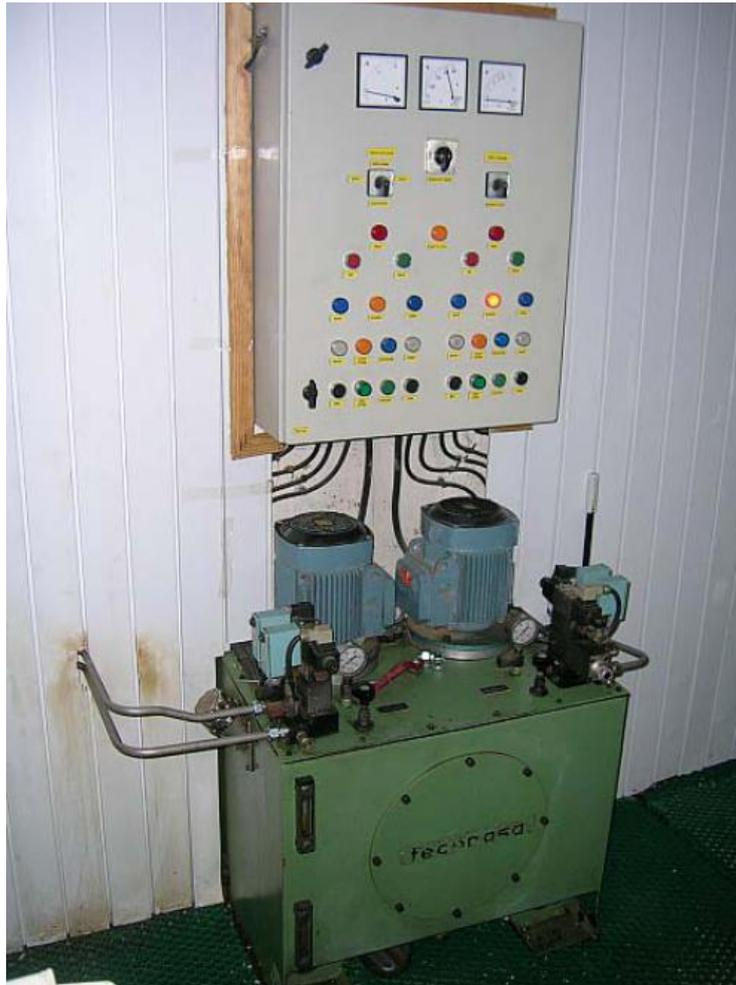
Figura Ñ.5: Grupo oleohidráulico y cuadro de maniobra del desagüe de fondo de la presa de Cervera.
