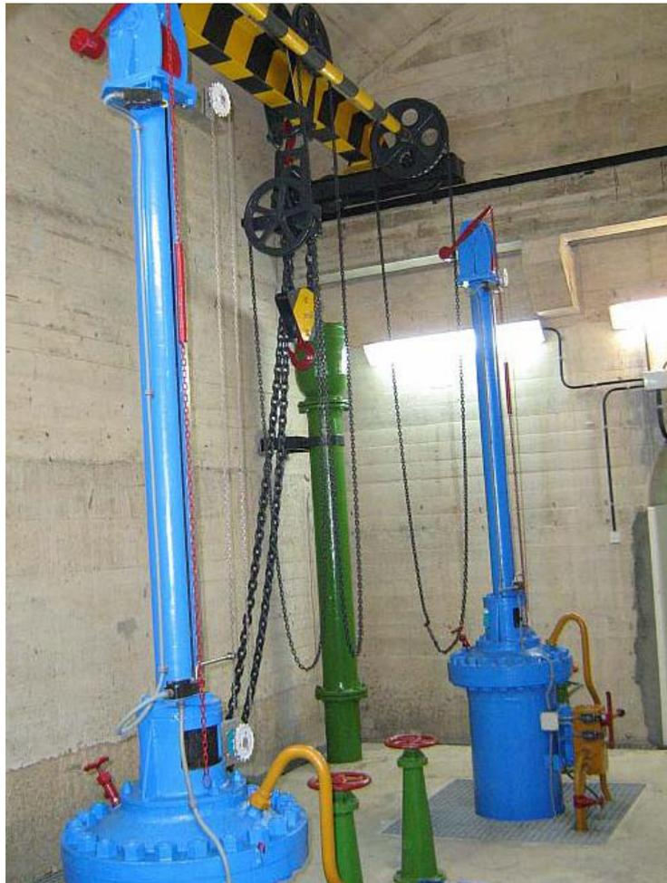
Figura Ñ.15: Válvulas Bureau de regulación del desagüe de fondo de la presa de Aguilar de Campoo.
