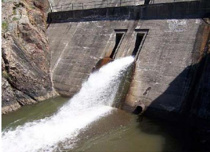
Figura Ñ.10: Desagüe por el conducto izquierdo del desagüe de fondo de la presa de Requejada.
