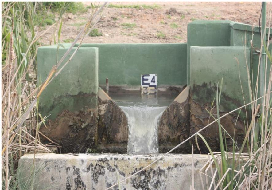
**Figura 24.** *Detalle Vertedero Triangular.*
