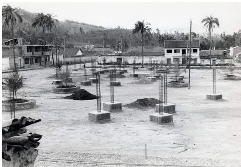
Imagen 41: y 42 Construcción de las kallampas 1971
