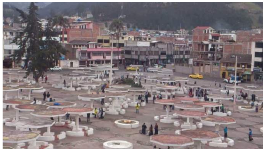
Imagen 46 y 47: Vista general donde se puede visualizar la inexistencia del área verde interior
