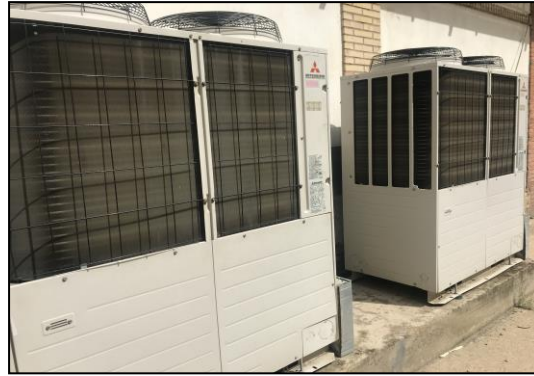
Ilustración 3. Equipos VRF
