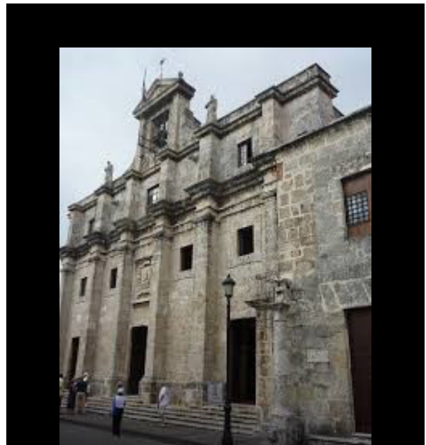
Figura 34. Fachada Principal Panteón Nacional.
