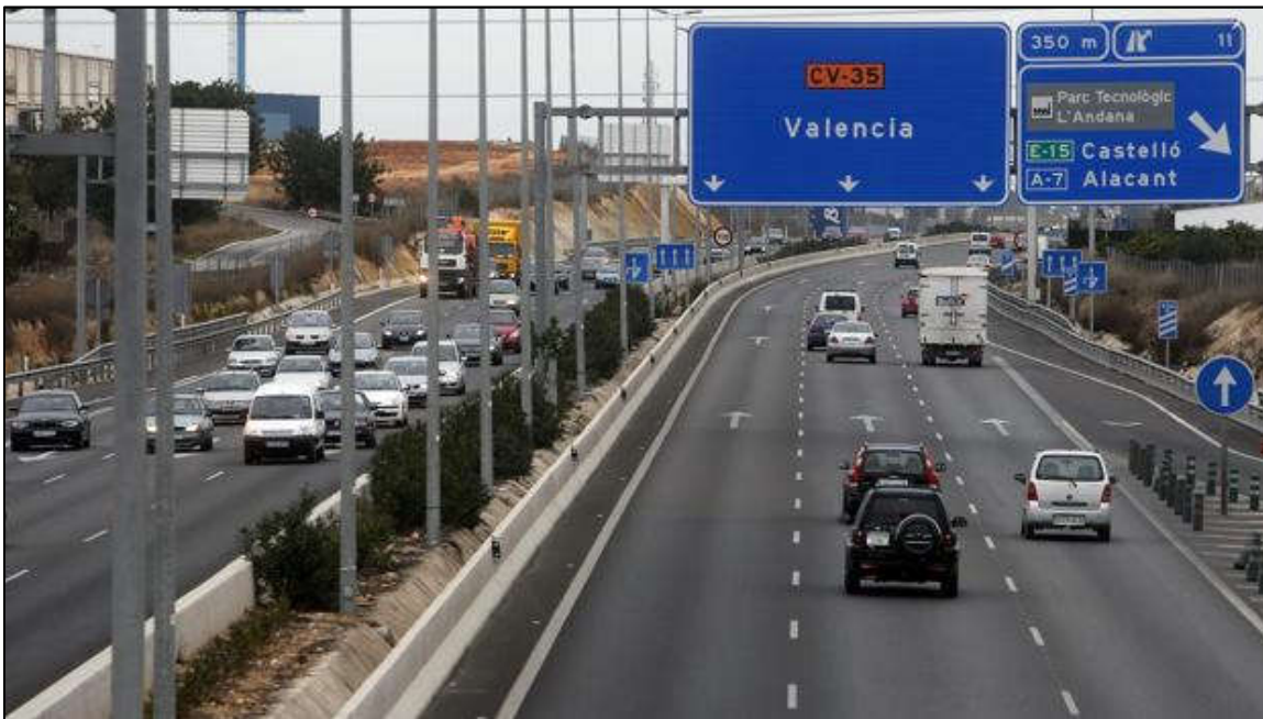
Figura 4 Fotografía de carretera CV-35.
