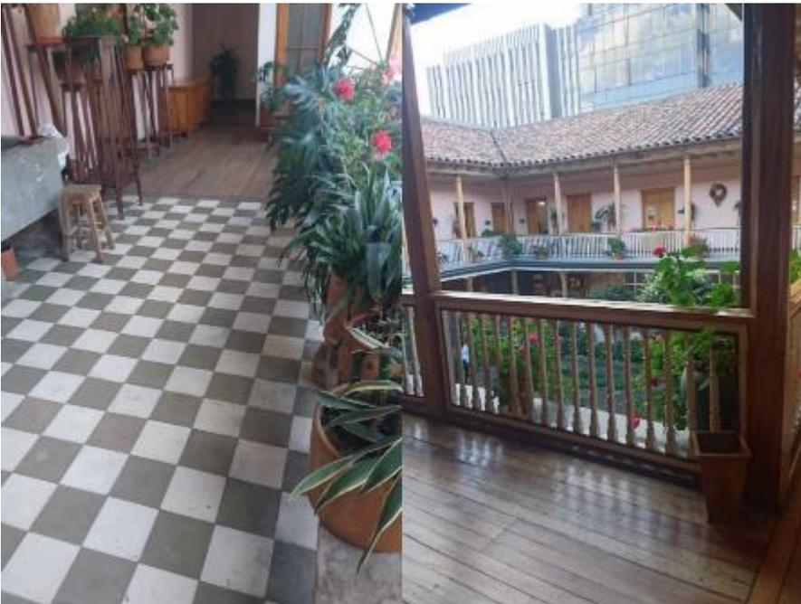
Figura 130 Pavimento de baldosa hidráulica y entablado, Pasillos segunda planta, Casa Zarama. Foto tomada por el autor.
