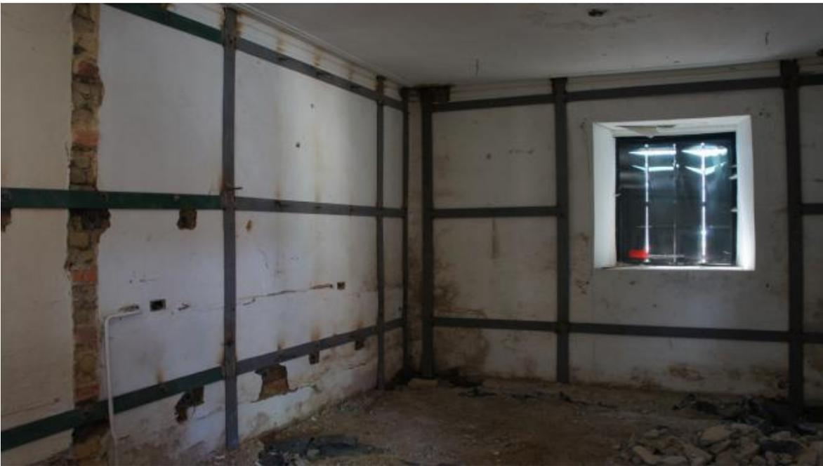
Figura 89 Refuerzo mediante platinas de acero. FUENTE: (Universidad de los Andes, 2018)
