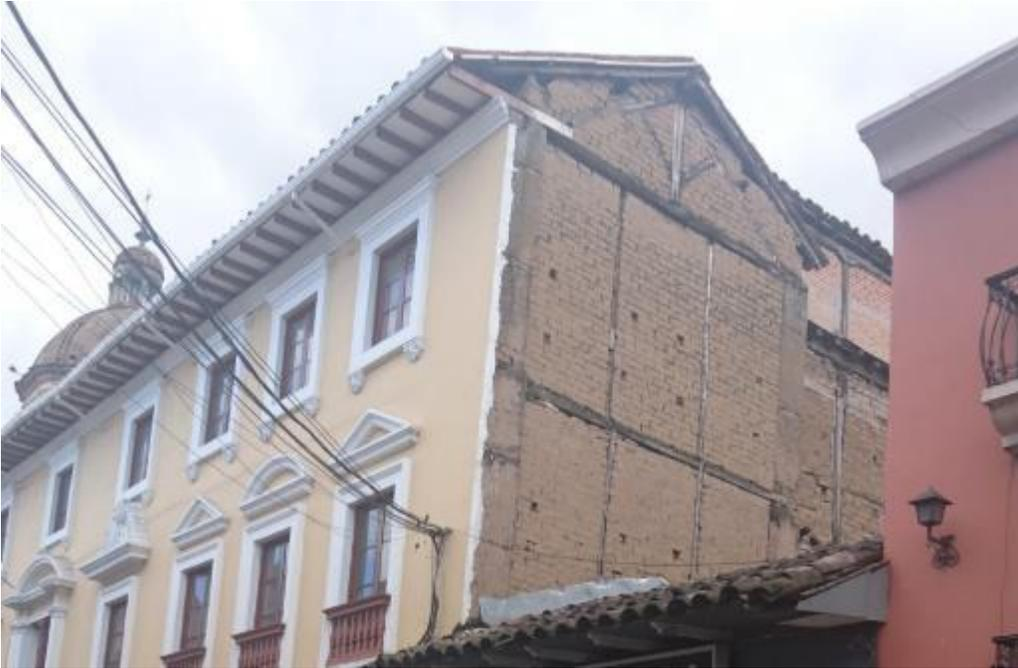
*Figura 120 Estructura de la culata y hastial en bloque de Adobe, Calle 18 No 26. Foto tomada por el autor.*
