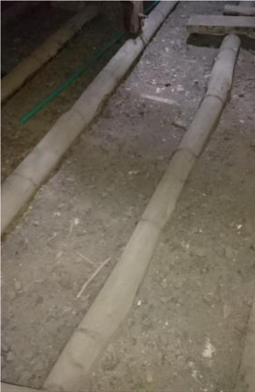
*Figura 157 Amarre de correas mediante alambre, Cubierta, Casa Zarama. Foto tomada por el autor.*
