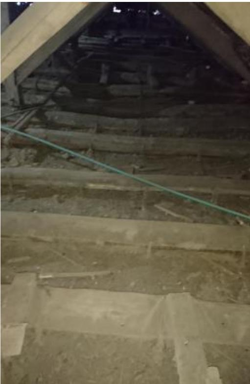
*Figura 158 Amarre de correas mediante cabestro, Cubierta, Casa Zarama. Foto tomada por el autor.*
