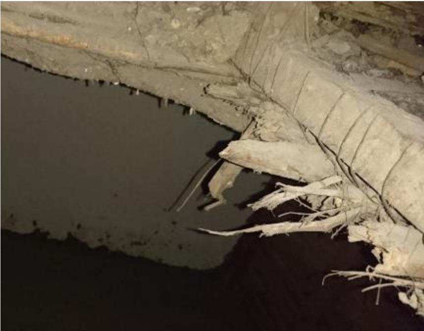
*Figura 156 Amarre con alambre de la chacla a las correas, Cubierta, Casa Zarama. Foto tomada por el autor.*
