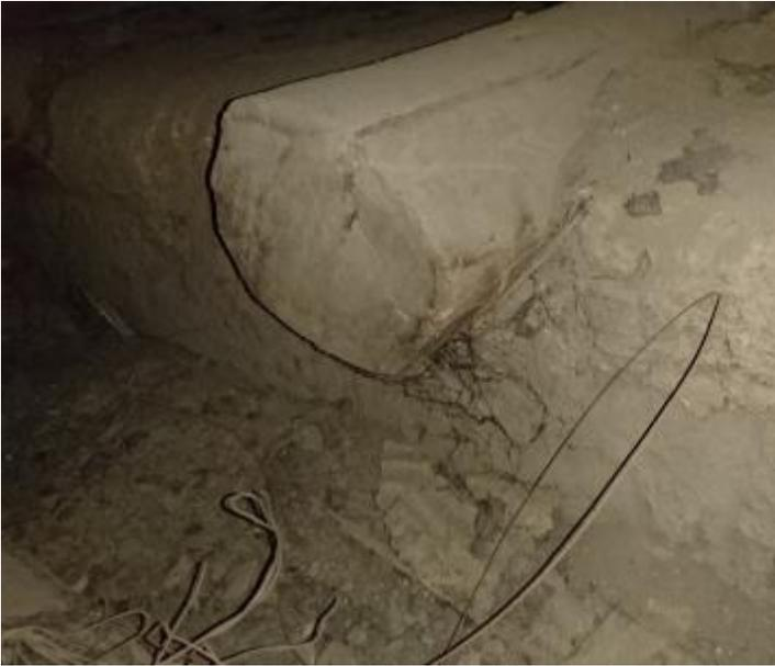
Figura 135 Unión muro de tapia y tirantes, con enrase de bloques de adobe "encoroce", Cubierta, Casa Zarama. Foto tomada por el autor.
