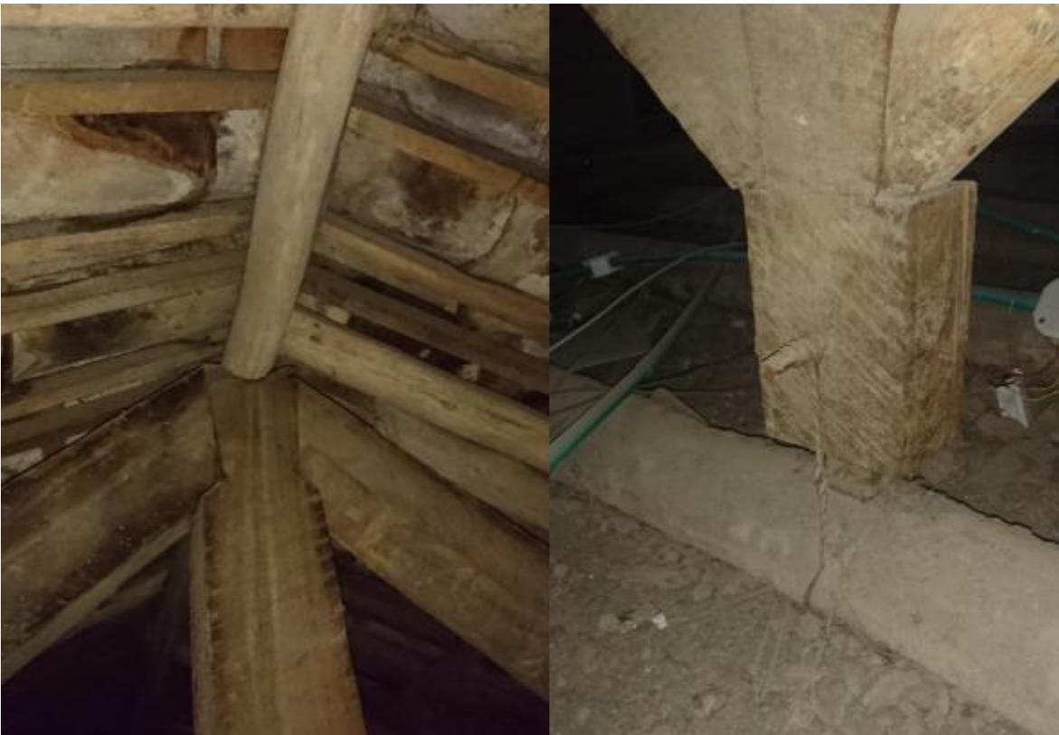
Figura 136 Unión en boca de pescado: pendolón -cubreras; Izquierda. Unión tipo espiga con refuerzo con alambre: pendolón - tirante. Derecha, Cubierta, Casa Zarama. Foto tomada por el autor.
