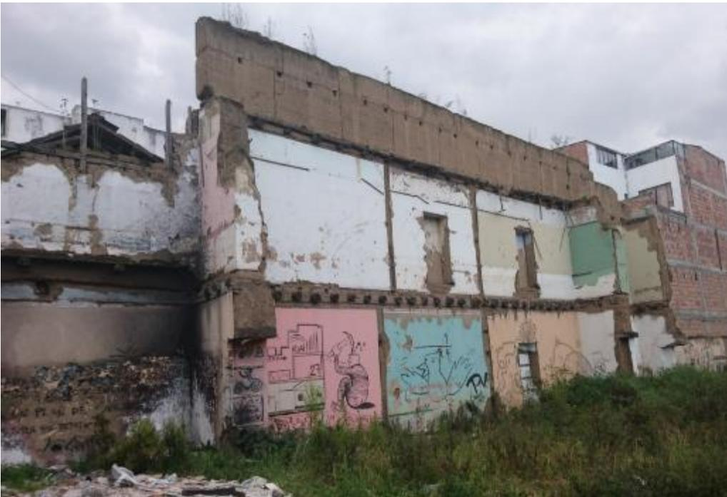
Figura 114 Corte muro de tapia cara interna a la vivienda. Carrera 27 No 15. Foto tomada por el autor.
