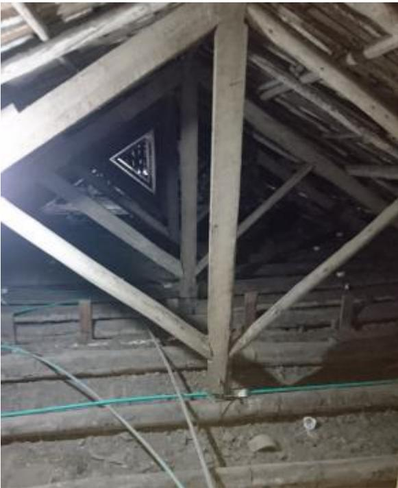
*Figura 138 Pares y tornapuntas de sección variables, Cubierta, Casa Zarama. Foto tomada por el autor.*
