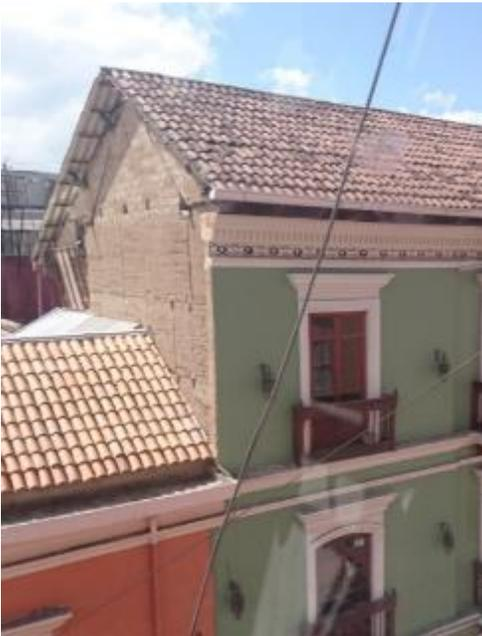
*Figura 152 Reparación de cubierta con láminas de Eternit y recubrimiento de tejas de barro, Casa Navarrete, Calle 17 No 24. Foto tomada por el autor.*
