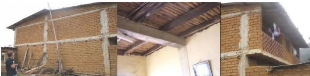
Figura 85 Sistema de confinamiento mediante vigas y columnas de concreto reforzado- Morropón, Piura. FUENTE: (San Bartolomé Ramos, 2014).
