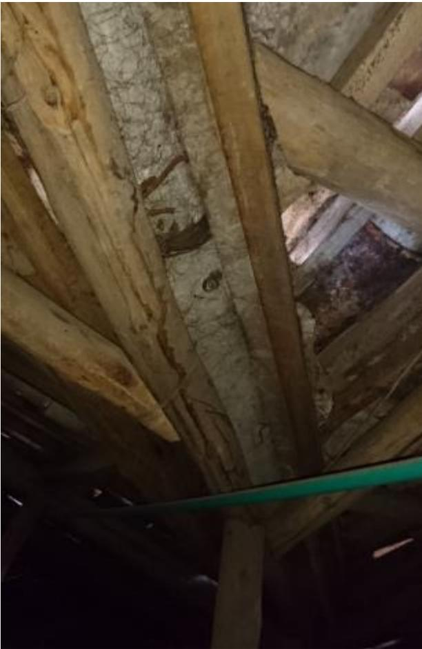
Figura 144 Lima hoyo. Unión entre dos planos mediante una canaleta, Cubierta, Casa Zarama. Foto tomada por el autor.
