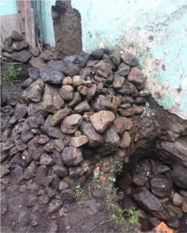
*Figura 105 Roca utilizada para la construcción de cimentación, Calle 10 No 25 – 10. Foto tomada por el autor.*
