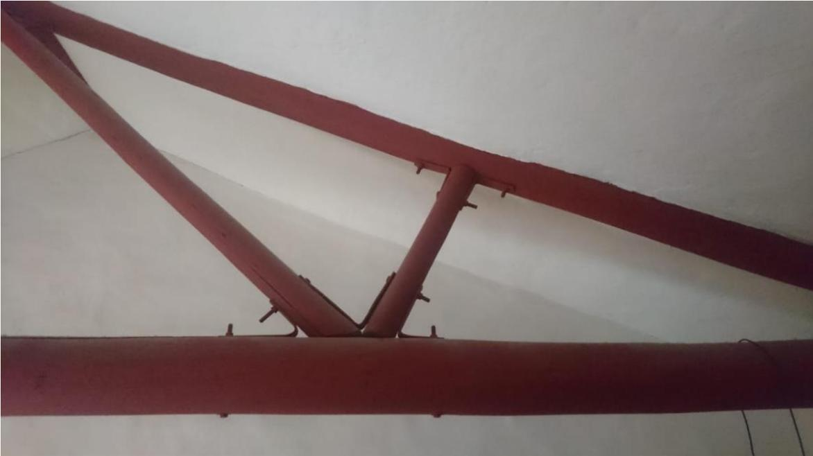
*Figura 165 Refuerzo con platinas metálicas y tornillos en las uniones de la cercha de cubierta, Casa Jose Antonio. Foto tomada por el autor.*
