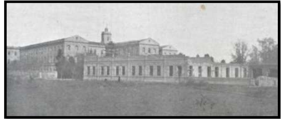
Fotografía Histórica 0 23.- Construcción Primer Bloque de las Escuelas San José.
