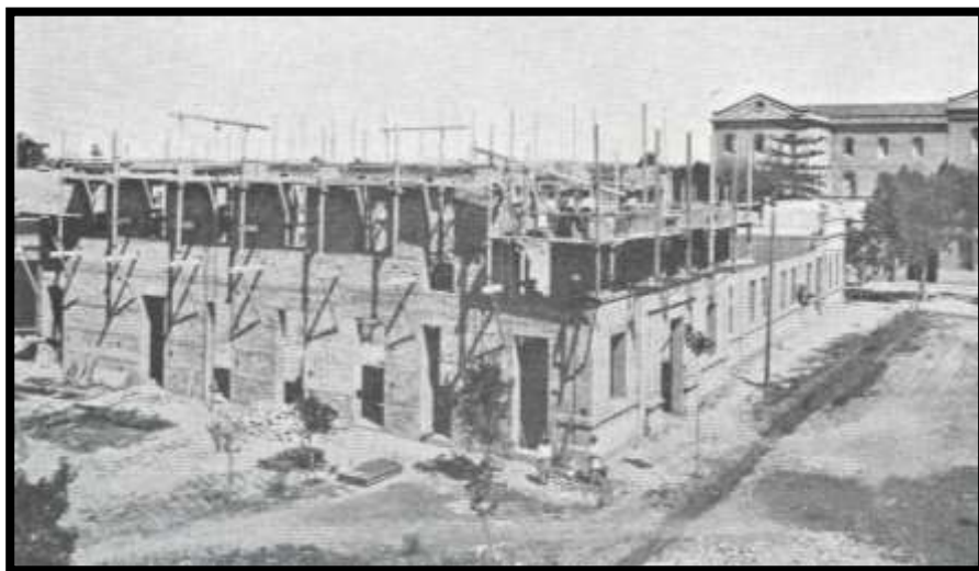
Fotografía Histórica 25.- Construcción de la Segunda Planta de las Escuelas San José. 1926. Fuente: Revista Auras pág. 287
