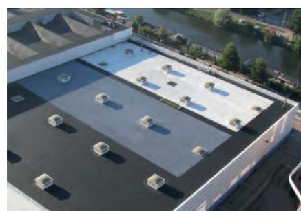
Ilustración 43. Pruebas con pinturas de diferentes colores sobre láminas bituminosas.
