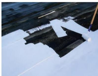
Ilustración 42. Proceso de pintado de lámina bituminosa.
