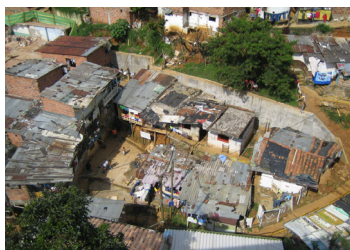
Figura 16 : Viviendas sin condiciones mínimas, Medellín
