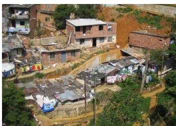
Figura 17 : Viviendas sin condiciones mínimas, Medellín
