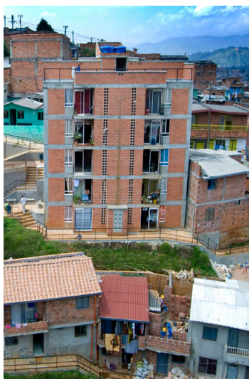
Figura 18: Viviendas sociales, Proyecto quebrada Juan Bobo
