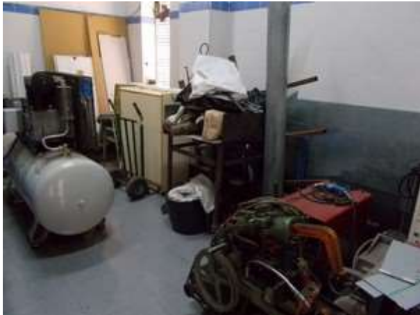
Riesgo 33: Almacenamiento de productos combustibles en sala de compresores.
