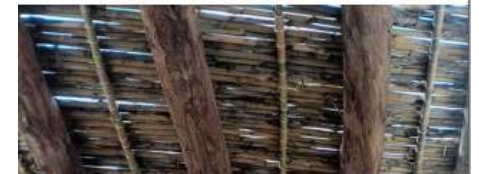
[FIG. 4.1v] Reparación de la cubierta del Proyecto de Ademuz llevado a cabo por Vegas, F. y Mileto, C. Fuente: Loggia nº17.
