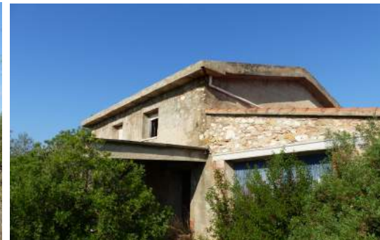
[FIG. 2.37] Encuentro intervención-existente. Fuente: Marta Martínez Talavera
