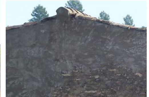
[FIG. 2.40] Encuentro intervención-existente. Fuente: Marta Martínez Talavera
