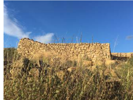
[FIG. 2.51] Imagen de construcción auxiliar. Fuente: Marta Martínez Talavera
