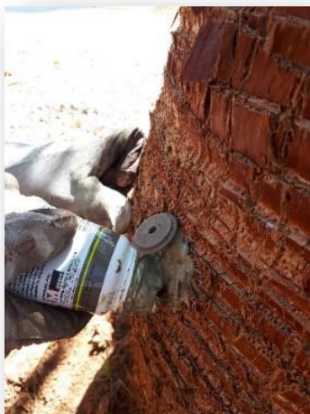
Figura 17. Matener estanqueidad con un mástic sellador
