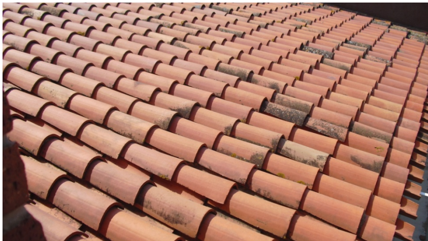
Figura 13 Ejemplo de cubierta transitable sobre tabiquillos. Fuente: propia.
