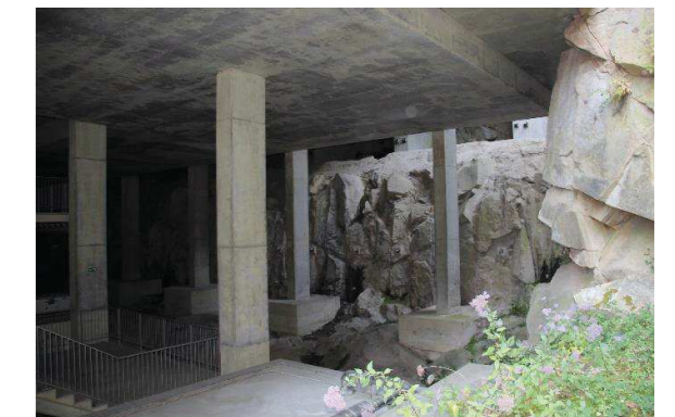
Fig. 35.5 Cimentación excavada en la roca
