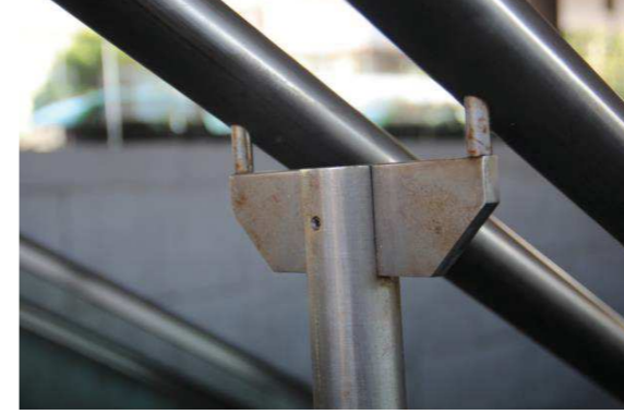
Fig. 30.24 Detalle Barandilla Estación Casa da Música
