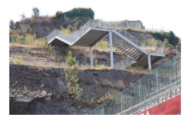
Fig. 35.13 Escalera en la ladera
