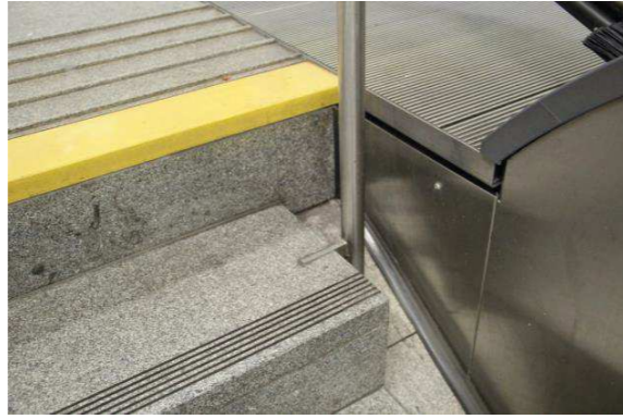
Fig. 30.14 Interior Estación 24 de Agosto
