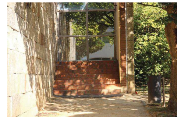
Fig. 5.3 Acceso al edificio
