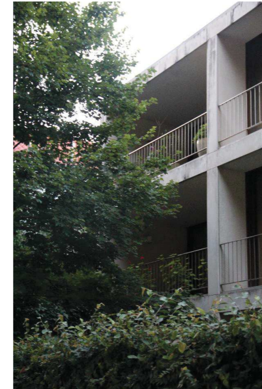
Fig. 23.4 Estado actual fachada
