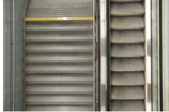
Fig. 30.17 Interior Estación 24 de Agosto
