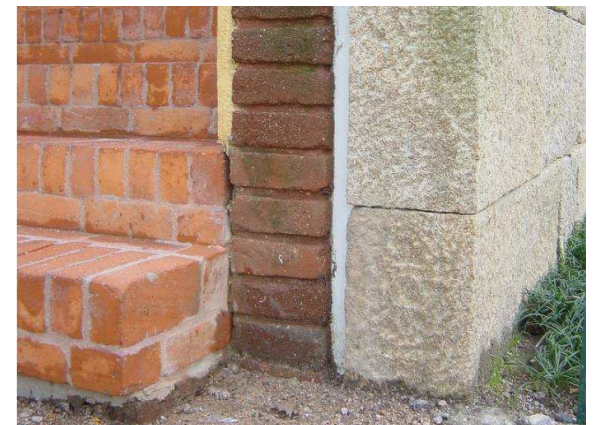
Fig. 5.5 Detalle del muro
