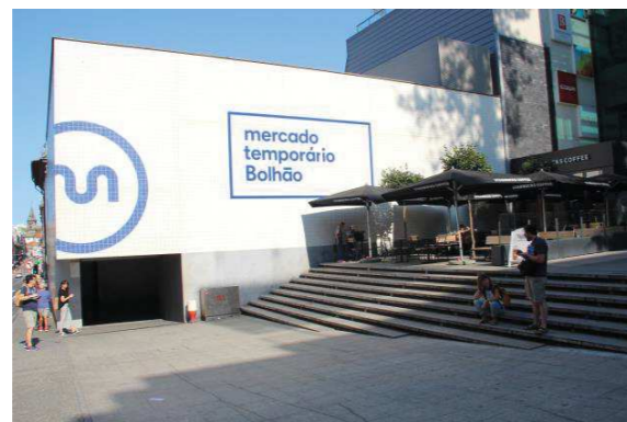
Fig. 30.19 Exterior Estación Bolhão
