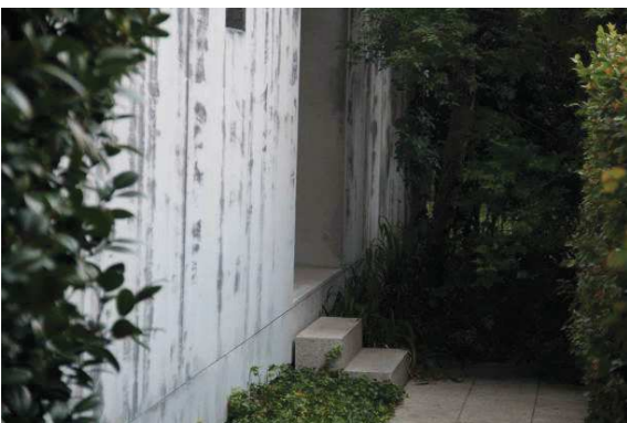
Fig. 23.3 Escalones acceso edificio
