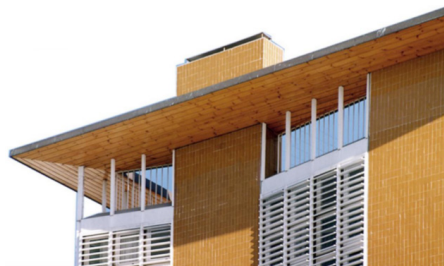
(Fig. 75): Detalle remate del edificio
