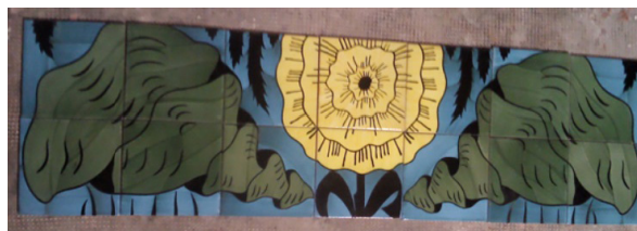
(Fig. 73): Detalle azulejos de fachada.
