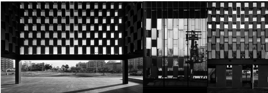
(Fig 93): Vistas de la fachada.
