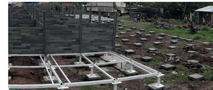
Imagen 56. Proceso constructivo https://goo.gl/jFKAwc
