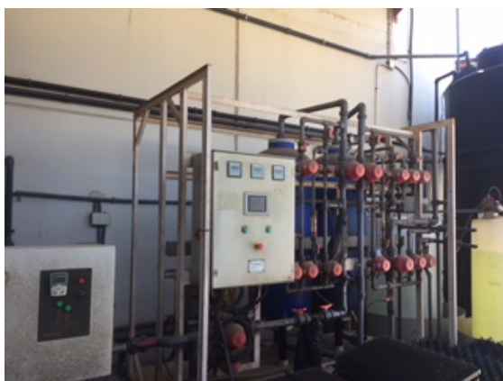
Figuras 16 y 17 equipo de osmosis inversa que hay en la planta actualmente y los filtros que utiliza
