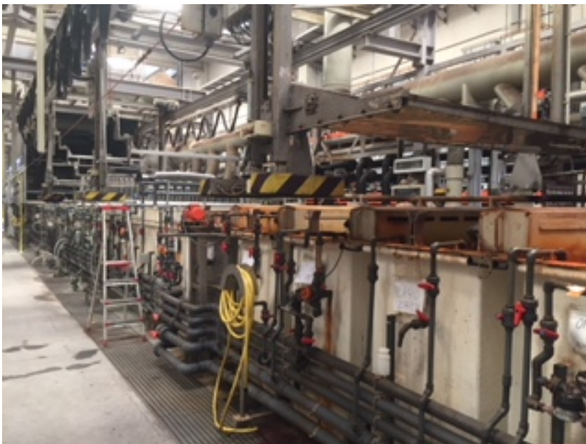
Figura 9: vista de la línea donde se pretende realizar el proyecto
