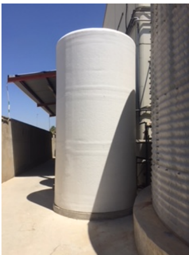
Figura 15: imágenes del posible silo de almacenamiento
