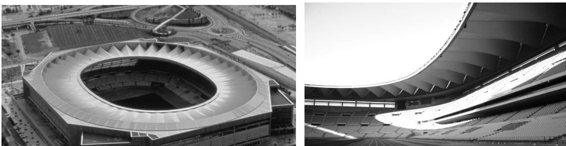
Fig. 83 y 84 Imágenes de la cubierta del Estadio Olímpico de la Cartuja
