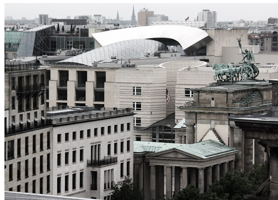
Fig. 77 Vista exterior del edificio con la puerta de Brandemburgo
