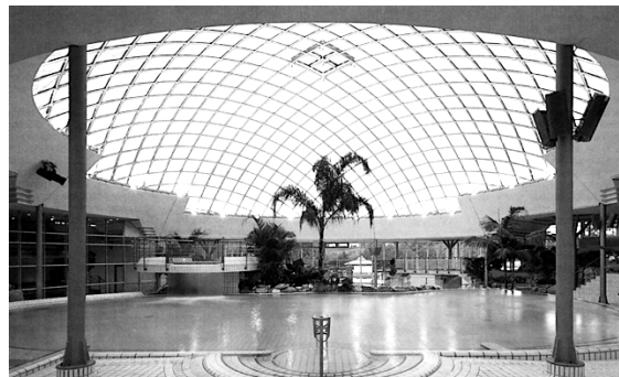
Fig. 61 Cubierta del Aquatoll en Neckarsulm, 1989 (Abajo)
