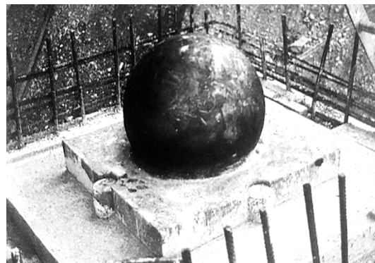
Fig. 45 Rótula para posicionar los mástiles inclinados, hechas de hormiÓN (Abajo)
