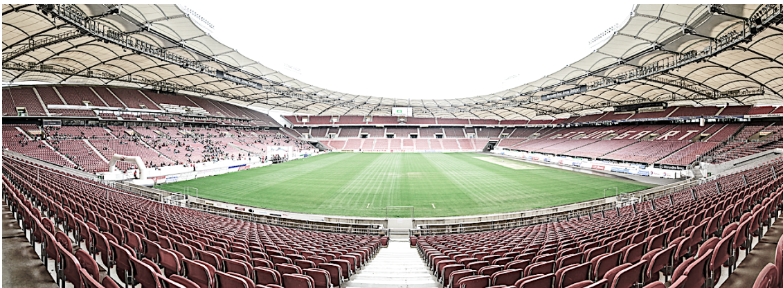
Fig. 96 Imagen del estado del estadio en la actualidad
