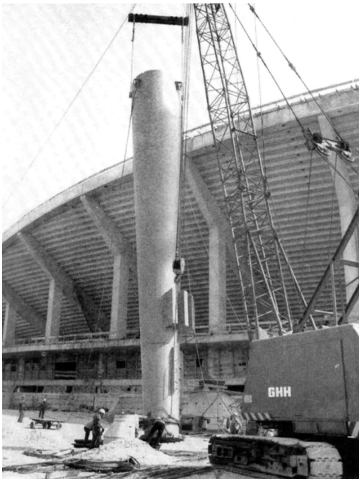
Fig. 46 Momento de colocación de la parte inferior de un mástil
