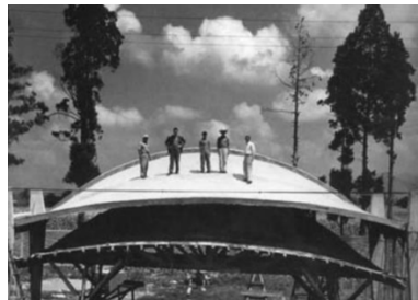
Fig. 11 Modelo experimental: conoide en la Fábrica de Fernández, San Bartolo, México (1950)
