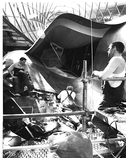
Fig. 75 Colocación de los paneles de acero inoxidable
