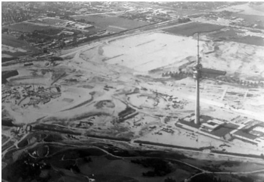
Fig. 37 Estado del lugar antes de la construcción
