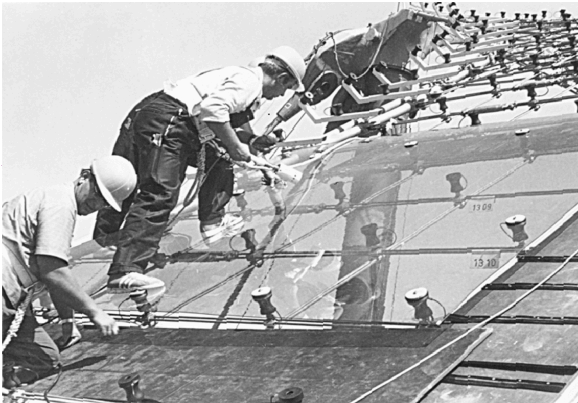
Fig. 57 Obreros colocando los paneles de plexiglás sobre la red de cables
