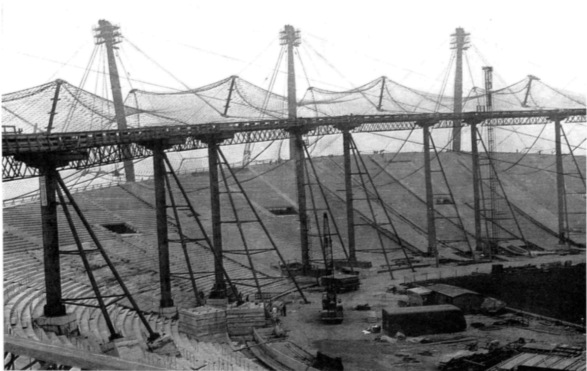
Fig. 56 Momento en el que se iba colocando y tensando la red
