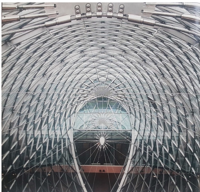
Fig. 71 Diferentes formas de rigidizadores de ruedas pretensadas
