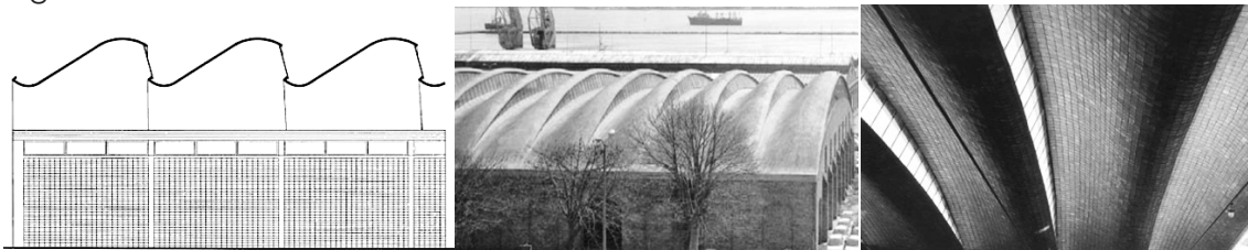
Fig. 16,17 Y 18. Sección de bóvedas Gausas, aspecto exterior e interior de una nave en Montevideo.
