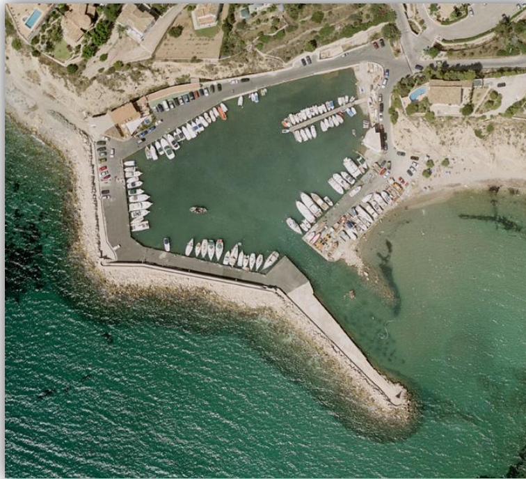
Fig. 3.28 Puerto Blanco, fuente: Conselleria de Vivienda, Obras Públicas y Vertebración del Territorio. Puertos
