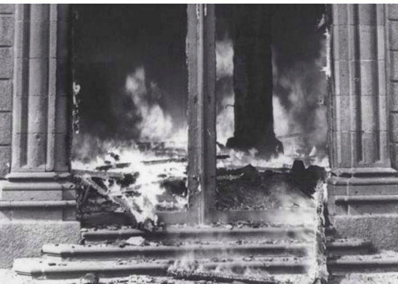
Figura 2.13. Fotografía desde el acceso lateral el día del incendio (Autor desconocido, 1964)
