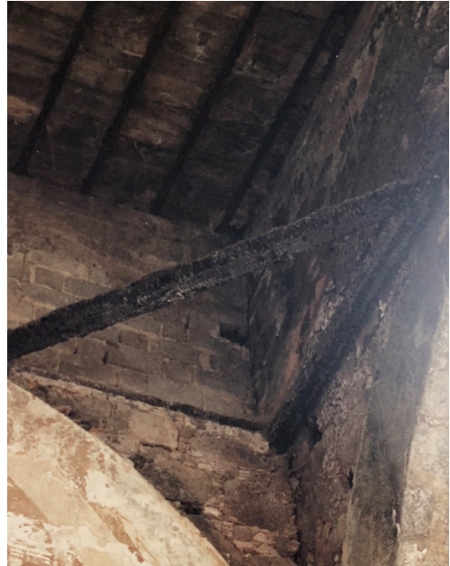
Figura 4.13. Techumbre del edificio anexo que cubre el altar mayor (Autor: Lorenzo Santana, 2008)
