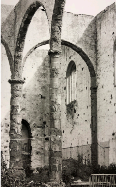
Figura 4.1. Estado de columnas (Autor: Javier Martínez, 1998)
