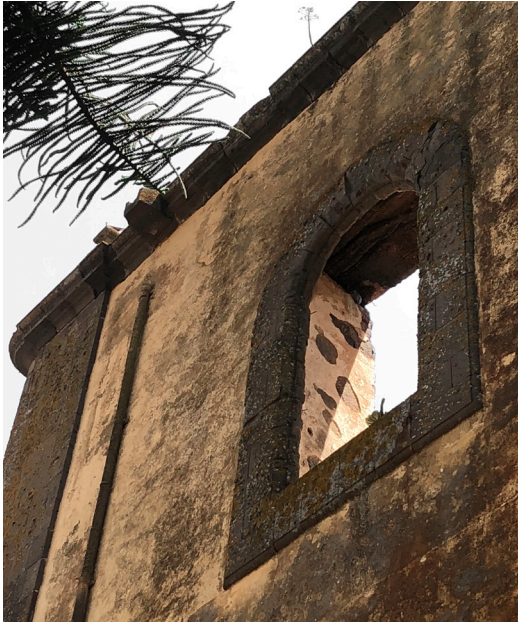
Figura 4.6. Colonia de líquenes en la fachada norte (Elaboración propia, 2018)
