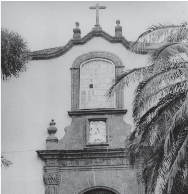
Figura 2.21. Fachada principal Iglesia de San Agustín, La Laguna (Adalberto Benítez, 1963)
