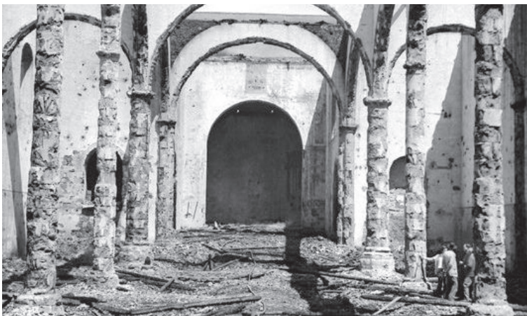
Figura 2.15. Escombros y ruinas tras el incendio (Agustín Guerra Molina, 1964)
