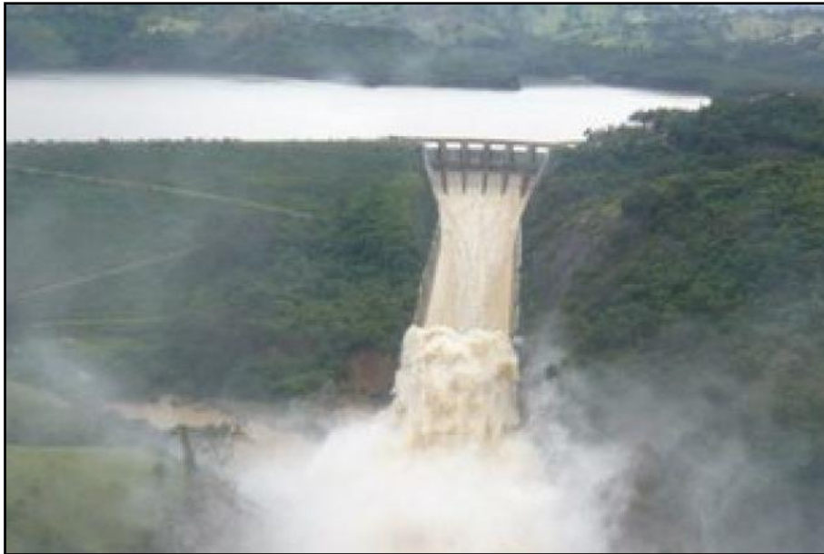
Figura 3. 4. Desagüe presa Tavera. Fuente: Imágenes Google
