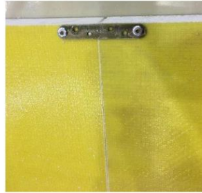
Fig. 5: Pletina metálica para fijación provisional o de montaje.
