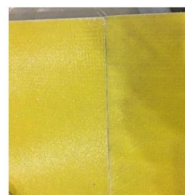
Fig. 4: Paneles fijados provisionalmente mediante adhesivo de montaje.
