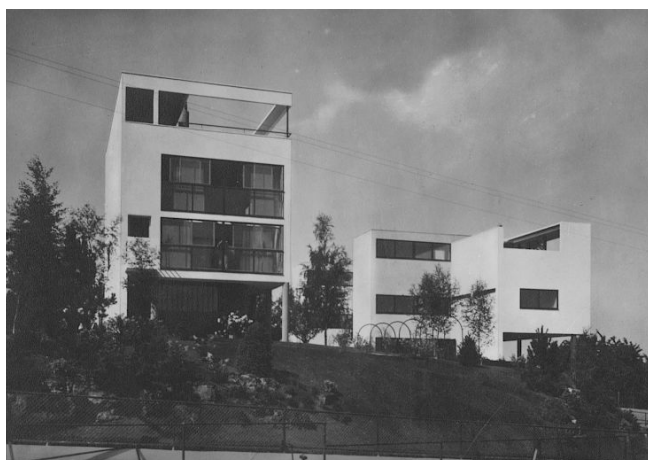
Fig. 4. - Vista aérea de las casas de Le Corbusier y Pierre Jeanneret, entorno a 1927
