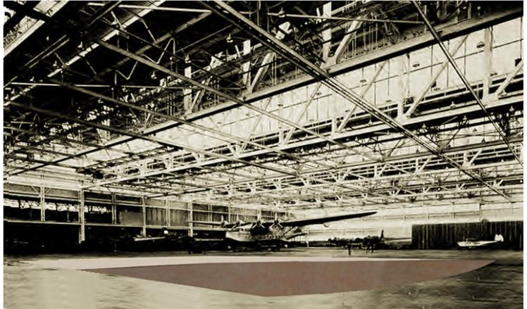
Fig. 4.3. El plano de techo queda definido por un panel horizontal suspendido de la estructura principal
