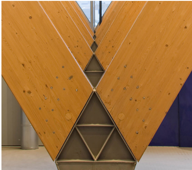
Fig. 40. Fotografía unión en la base del arco. Fuente: ROGERS, STIRK, HARBOUR + PARTNERS. < https://www.rsh-p.com >
