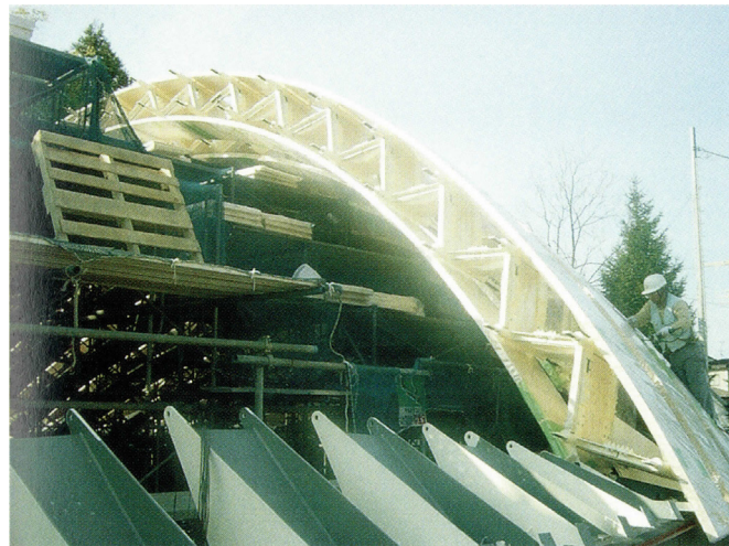
Fig. 88. Fotografía estructura metálica. Fuente: McQuaid, Matilda., (2006), SHIGERU BAN, Londres, Reino Unido: Phaidon.
