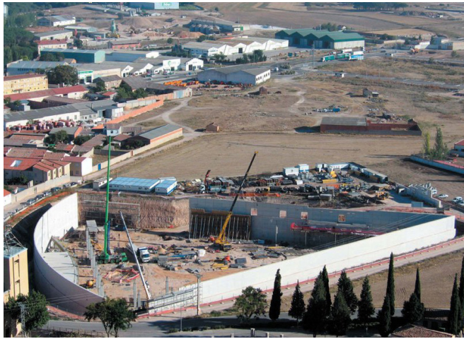
Fig. 45. Construcción de muros perimetrales y cimentación. Fuente: RSH + PARTNERS. < https://www.metalocus.es >
