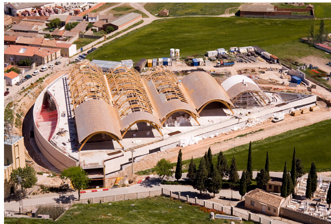
Fig. 50. Construcción de la cubierta. Fuente: RSH + PARTNERS. < https://www.rsh-p.com >
