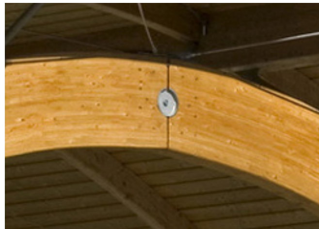
Fig. 43. Fotografía unión centro de arco. Fuente: ARQUITECTURAS CERÁMICAS. < http://www.ceramicarchitectures.com >
