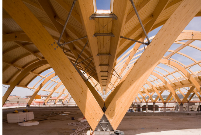
Fig. 49. Construcción de la cubierta. Fuente: RSH + PARTNERS. < https://www.rsh-p.com >
