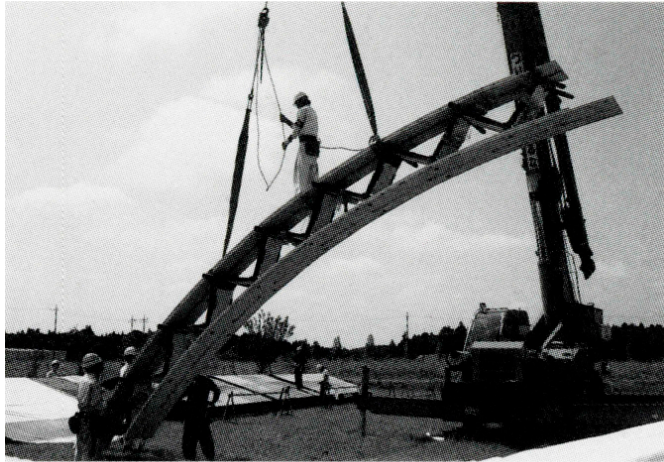
Fig. 85. Montaje parcial del arco. Fuente: McQuaid, Matilda., (2006), SHIGERU BAN, Londres, Reino Unido: Phaidon.
