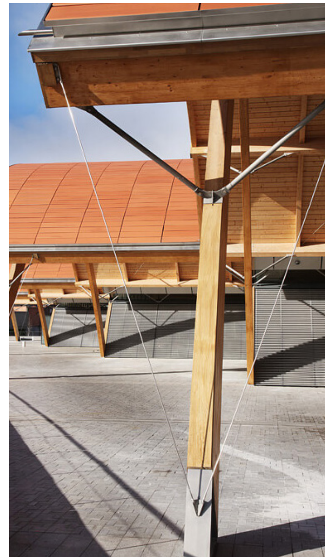
Fig. 39. Fotografía tensores laterales. Fuente: ROGERS, STIRK, HARBOUR + PARTNERS. < https://www.rsh-p.com >
