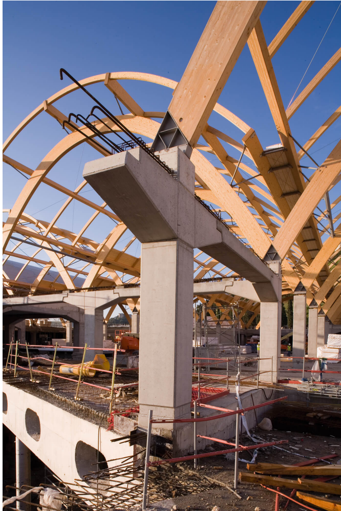
Fig. 48. Instalación de los arcos. Fuente: RSH + PARTNERS. < https://www.rsh-p.com >
