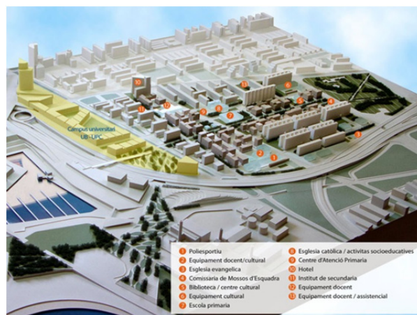
Ilustración 57. Maqueta explicativa de la actuación del Plan especial de transformación urbana del barrio La Mina, en Barcelona. Fuente: Jornet, Llop, Pastor Arquitectos.
