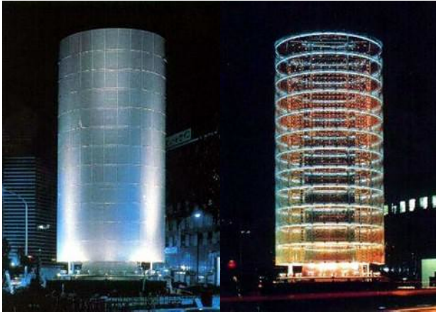
Figura 3. Tower of the Winds . Luminaria apagada (izq.) y encendida (der.).
