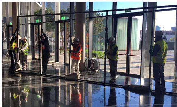
Figura 39. Acrisolamiento de la planta baja
