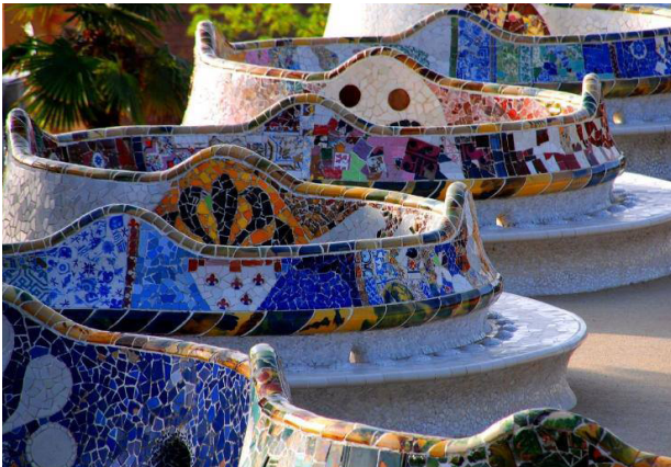
Figura 20. Detalle del trencadís en los bancos serpentinados del Parc Güell.
