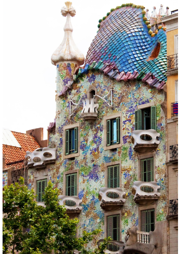
Figura 21. La fachada de la casa Batlló en detalle.
