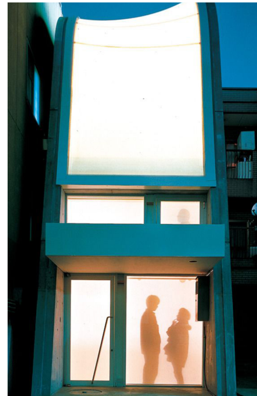
Fig. 55. FOBA. Project AURA. Fachada.
